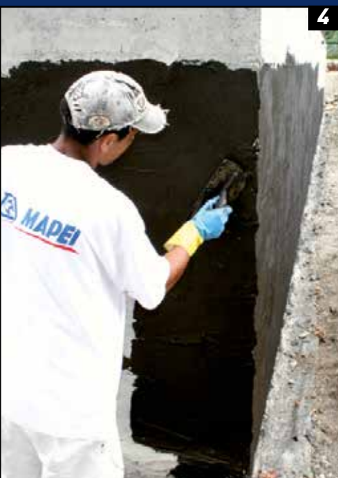
4. Hydroizolácia nadzákladového muriva
