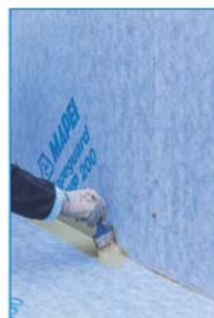
Nanos lepila Mapeguard WP Adhesive za lepjenje tesnilnega traku Mapeguard ST.
