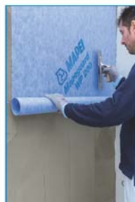
Vgradnja membrane Mapeguard WP 200.
