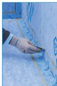
Vgradnja tesnilnega traku Mapeguard ST.
