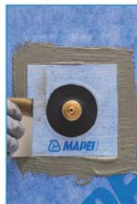
Vgradnja tesnilne mansete Mapeguard PC.
