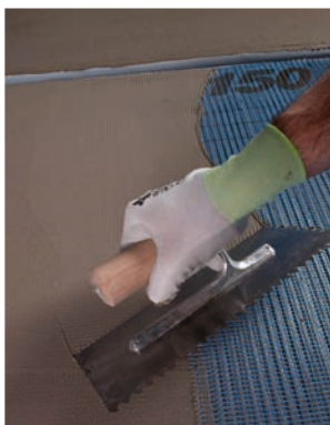
Vgradnja armirne mrežice Mapenet 150.
