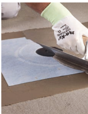
Vgradnja tesnilne manšete Drain Vertical z nanosom Mapelastic-a.
