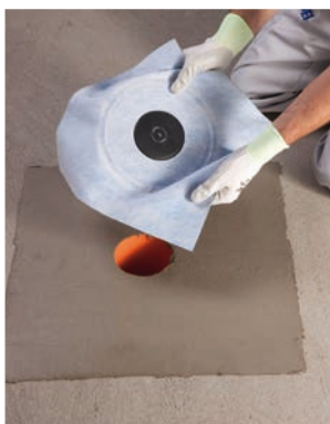
Vgradnja tesnilne manšete Drain Vertical z nanosom Mapelastic-a.
