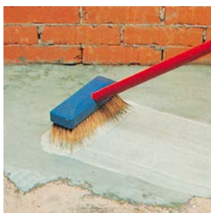
Nanašanje cementnega prijemnega sloja (pačok) izboljšanega s Planicrete -jem.
