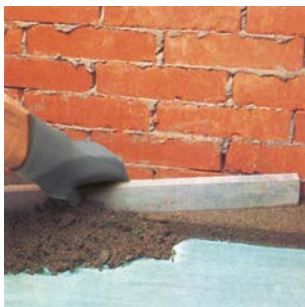
Vgradnja cementnega estriha na sveži sprijemni sloj (pačok) izboljšanega s Planicrete -jem.
