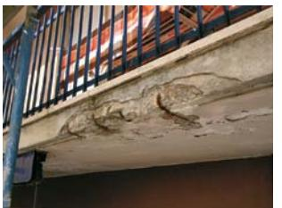
Odstranjevanje poškodovanih delov in čiščenje površine
