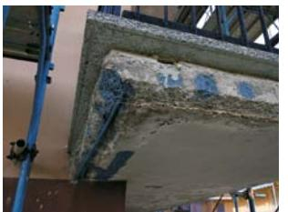
Zaščita armature z **Mapefer 1K** antikorozivskim premazom
