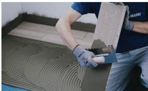
Vgradite izbrane keramične ali kamnite ploščice z **Mapei** ustreznim lepilom, razreda C2 ali višje (kot na primer **Adesilex P9 Express**).
