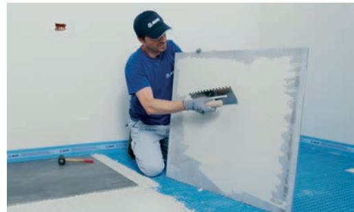
Vgradite izbrane keramične ali kamnite ploščice z **Mapei** ustreznim lepilom, razreda C2 ali višje.
