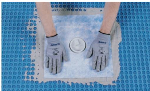
Vgradnja vertikalnih in horizontalnih odtokov z uporabo **Drain Front** in **Drain Lateral**.
