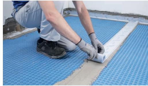
Stike med tesnilno membrano zatesnimo z uporabo **Mapeband Easy** tesnilnih trakov in lepilom **Mapeguard WP Adhesive** (3 mm široki stiki).
