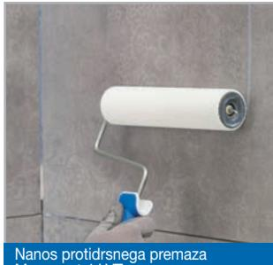
Nanos protidrsnega premaza Mapecoat 4 LVT.
