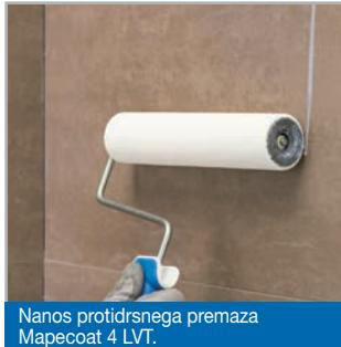
Nanos protidrsnega premaza Mapecoat 4 LVT.
