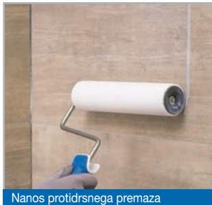
Nanos protidrsnega premaza Mapecoat 4 LVT.
