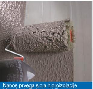
Nanos prvega sloja hidroizolacije Mapelastic Turbo z valjčkom.
