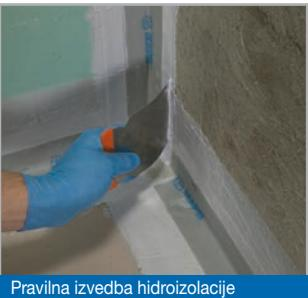
Pravilna izvedba hidroizolacije notranjega vogala z Mapeband Easy.
