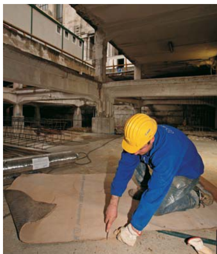
Priprava Mapeproof geotkanine pred vgradnjo
