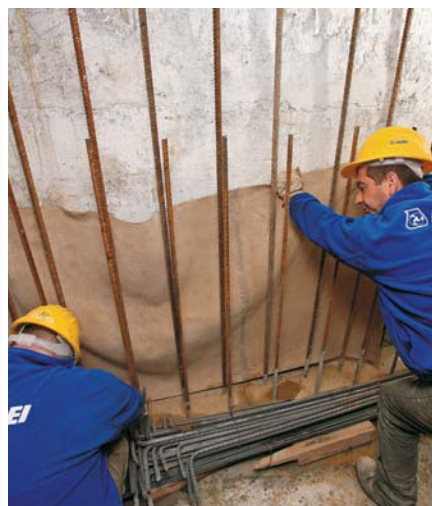
Vgradnja Mapeproof geotkanine
