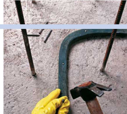
Pritrjevanje bentonitnega traku Idrostop B25 na betonsko podlago
