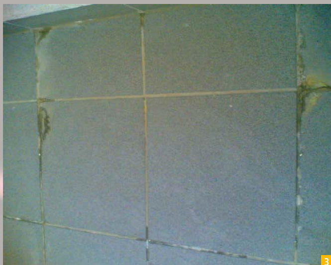
Slika 3: Prisotnost kapilarne vlage v podlagi povzroča na površini fug izcvetanje soli
