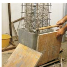
Obnova z enokomponentno malto za vlivanje z visokimi mehanskimi lastnostmi
