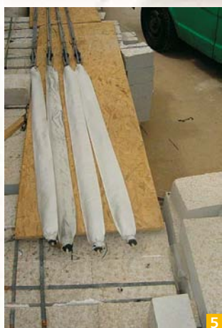
Slika 9: Prekrivanje sidranja z Mapewrap tkanino
