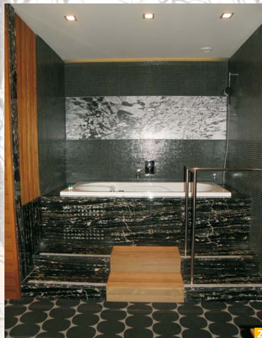
Slika 3: Keramične ploščice za fufugirane s cementno fufurno maso Ultracolor Plus, stekleni mozaik pa s Keracolor FF, kateremu je bil dodan Fugolastic
