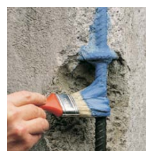
Zaščita armaturnih palic z izdelkom Mapefer
