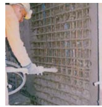
Strojni nanos sanacijske malte z brizganjem
