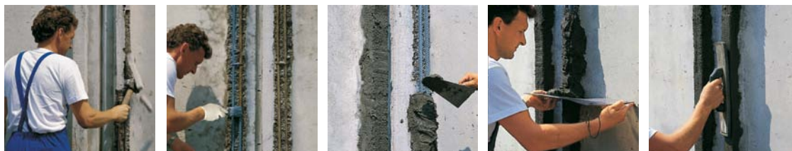
Obnova zaščitnega sloja betona nad armaturo z enokomponentno tiksotropno malto z običajnim časom vezave
