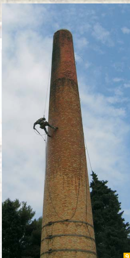
Slika 8: Odstranjevanje strelovoda, obstoječe betonske kape in opeke
