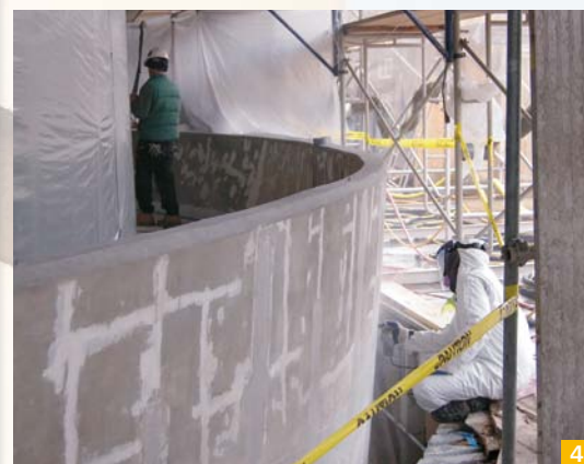
Slika 5: Nanašanje elastično dekorativne barve Elastocolor z razpršilno pištolo
