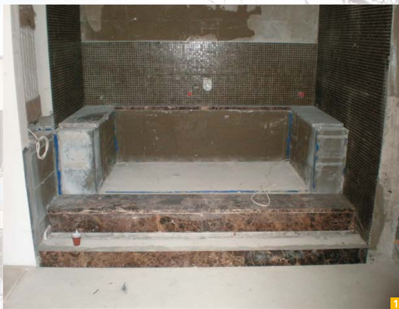
Slika 1: Izvedba tesnilnega sistema Mapelastic z Mapeband trakovi na stensko talnih regah
