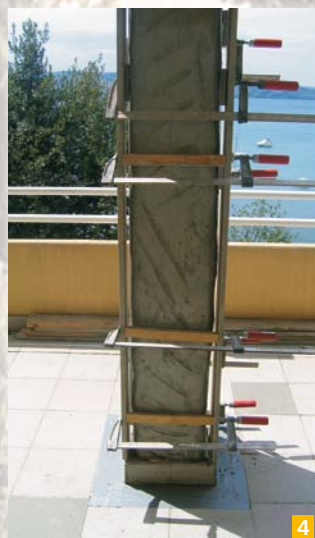
Slika 1: Odstranitev poškodovanega dela betona do zdrave in čiste hrpave podlage
