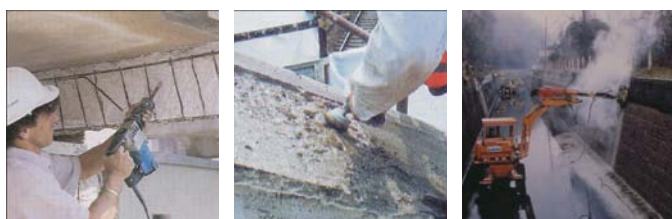
Odstranjevanje poškodovanega betona
