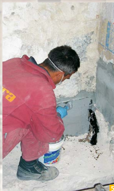
Slika 2: Injektorski nastavki v kamnitem zidu pred injektiranjem
