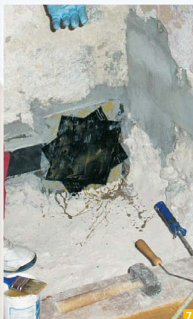
Slika 6: Preklop karbonske vrvice MapeWrap C Fiocco na pripravljeno podlago z epoksidno smolo MapeWrap 31
