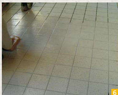
Slika 6: Takojšnje čiščenje površin po fugiranju z namenskimi čistilnimi gobami – filci
