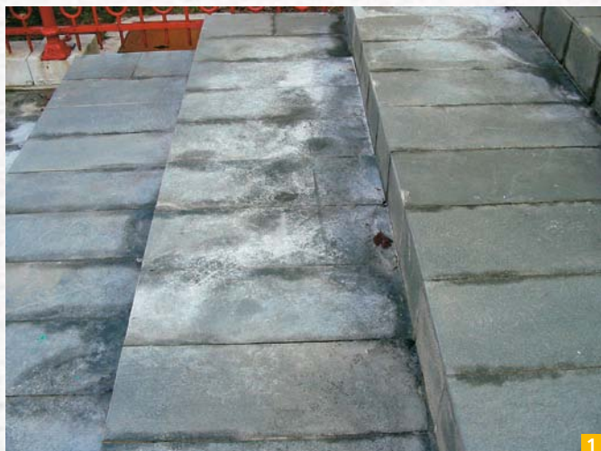
Slika 1: Izločanje solitra iz cementne malte
