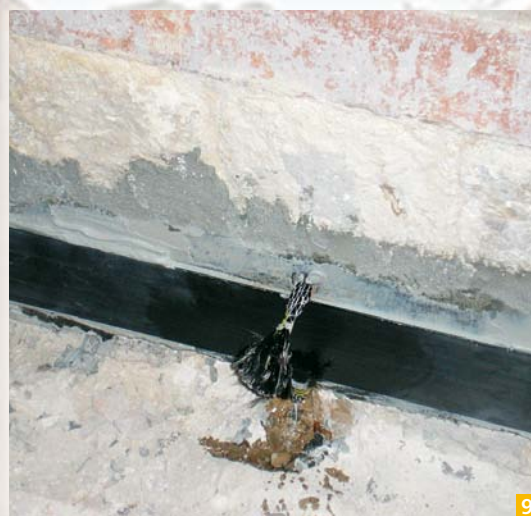
Slika 7: Preklop karbonske vrvice MapeWrap C Fiocco s karbonsko tkani- no MapeWrap C UNI-AX
