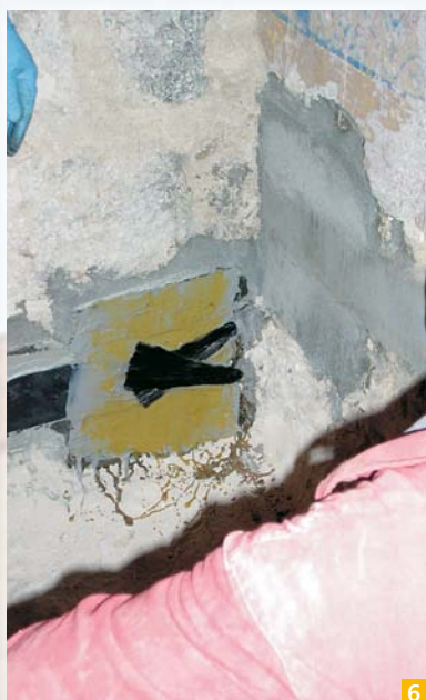
Slika 6: Preklop karbonske vrvice MapeWrap C Fiocco na pripravljeno podlago z epoksidno smolo MapeWrap 31
