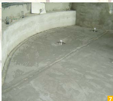
Slika 7: Izravnane bazenske površine so bile pod zaključno oblogo zatesnjene s tesnilno maso Mapelastic
