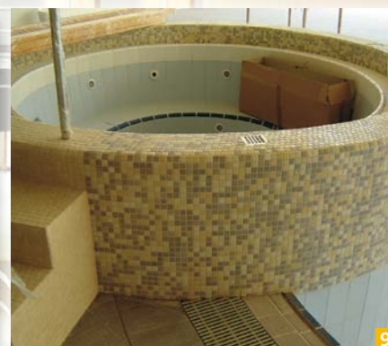
Slika 9: Keramični mozaik v whirlpoolu zafugiran s Ultracolor Plus fugirno maso
