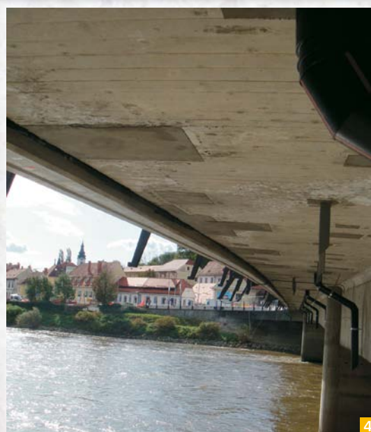
Slika 3: Razširitev vozne plošče in izgradnja pločnikov v delu in po njej
