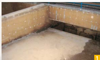
Slika 1: Priprava podlage in čiščenje armature pred obnovo
