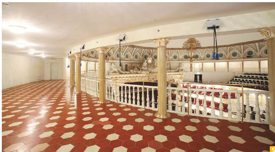
Slika 5: V galeriji, ložah in hodnikih so polagali šesterokotne marmete z lepilom Keraflex Maxi S1
