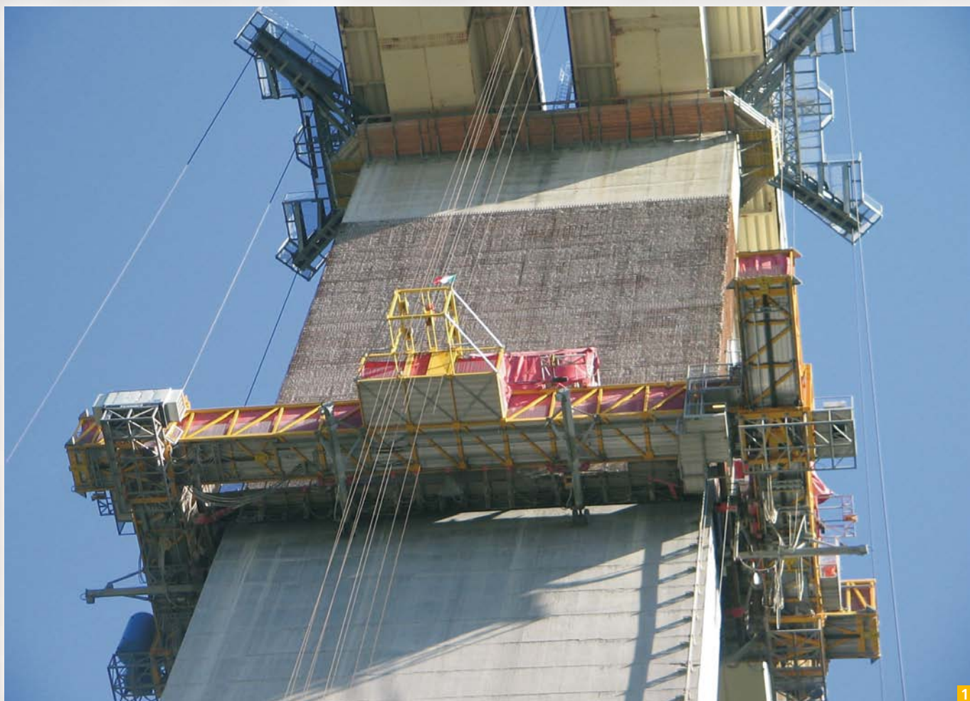
Slika 1: Hidrodinamični postopek priprave podlage na nosilnem stebru viadukta
