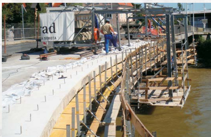
Slika 3: Razširitev vozne plošče in izgradnja pločnikov v delu in po njej
