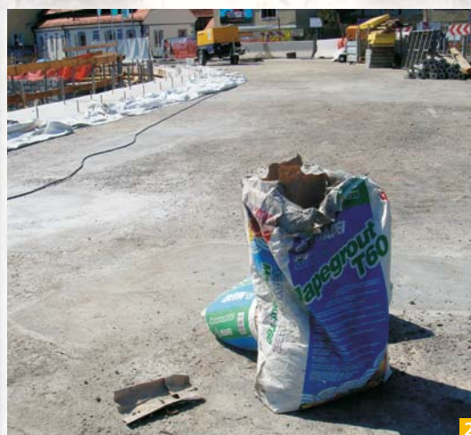
Slika 1: Vidne poškodbe betona in armature na vozni plošči pred sanacijo
