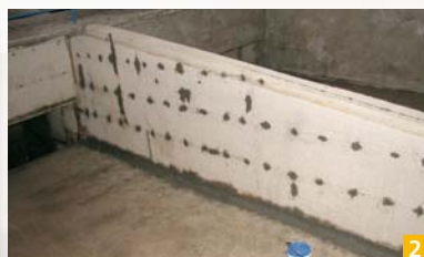
Slika 1: Priprava podlage in čiščenje armature pred obnovo
