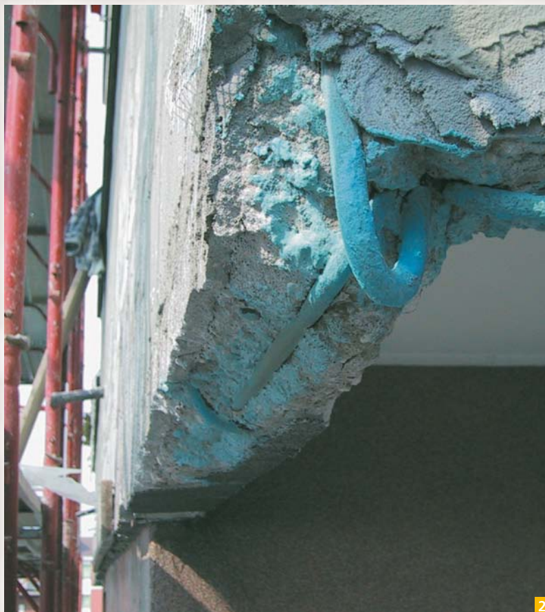
Slika 2: Nanesen protikorozivni sistem Mapefer na očiščeno armaturo
