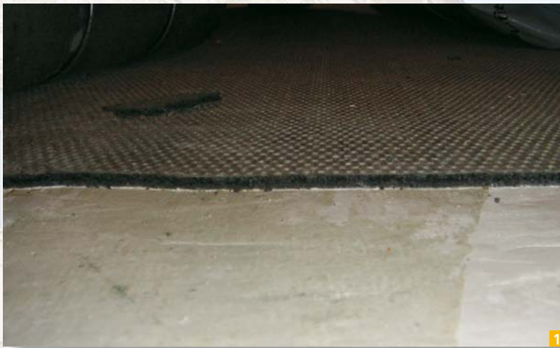
Slika 3: Lepljenje nove tekstilne obloge na podlago Durafit 500 se je izvedlo z disperzijskim lepilom v vodni disperziji Aquacol T
