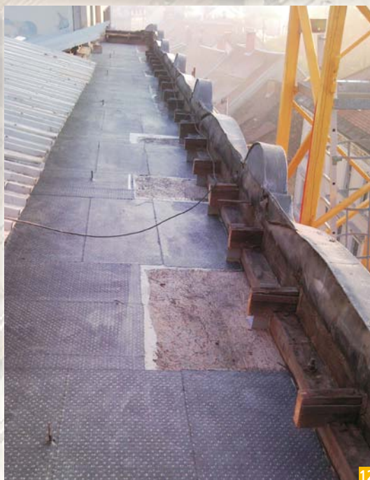
Slika 11: Nanos MapeWrap Primer-ja 1 na AB konzolo
