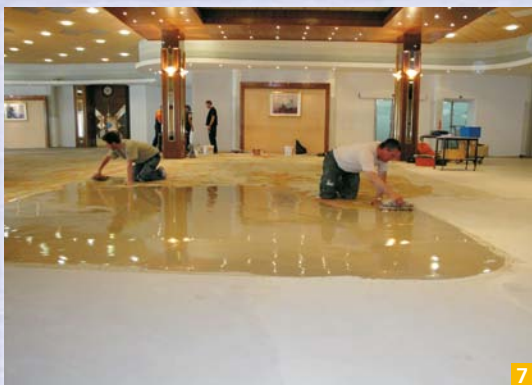
Slika 7: Izravnava obstoječe podlage z Ultraplan Eco pred polaganjem talnih oblog
