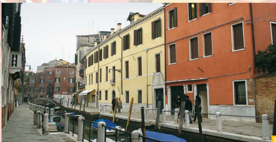
Slika 9: Ko je bil popolnoma odstranjen stari omet, smo nanegli plast Mape-Antique Rinzafo; stene so bile nato izravnane z izsuševalno malto Mape-Antique MC; ko se je vse popolnoma posušilo, je bilo pročelje obdelano s Silancolor Primer, na katerega je bila nanešena 0,7 mm debela plast Silancolor Tonachina v dveh različnih barvah ter v beli barvi za zaključni venec stavbe
