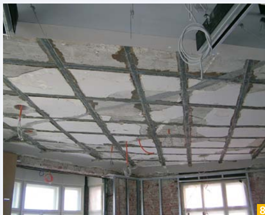
Slika 7: Pogled na izvedeno sanacijo ležišč
