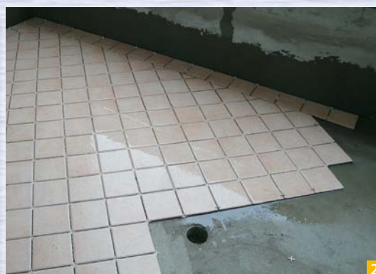
Slika 1: Tesnjenje balkonov z Mapelastic-om
