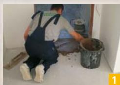
Slika 1: Nanos hitrosušee izravnalne mase Nivorapid, ki omogoča nadgradnjo že po nekaj urah
