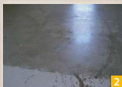
Slika 1: Nanos hitrosušee izravnalne mase Nivorapid, ki omogoča nadgradnjo že po nekaj urah
