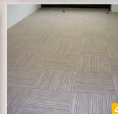
Slika 4: Tekstilne obloge v ploščah, lepljene z ekološkim lepilom Ultrabond Eco Fix
