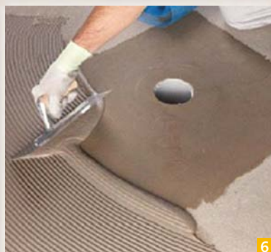
Slika 5: Vgradnja vertikalnega odtoka – Drain Vertical v kontaktni sloj Mapelastica
