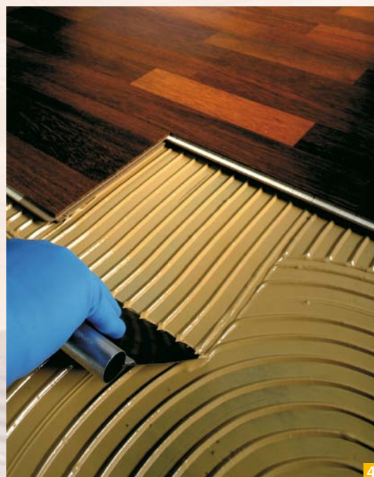
Slika 4: Izbor ustreznega lepila je odvisen od priporočenih smernic ter od posebnih pogojev in zahtev
