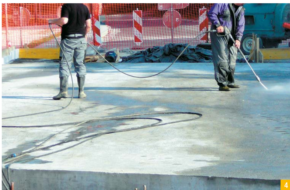
Slika 4: Priprava podlage – visokotlačno pranje AB konstrukcije.
