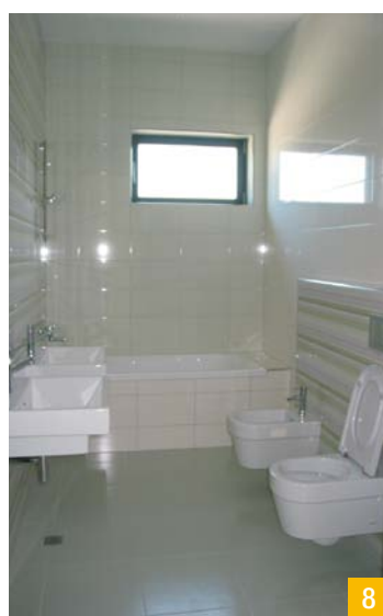
Slika 6: Sanitarije po- slovnega dela – stene so zaključene, na tleh je viden Mapelast.
