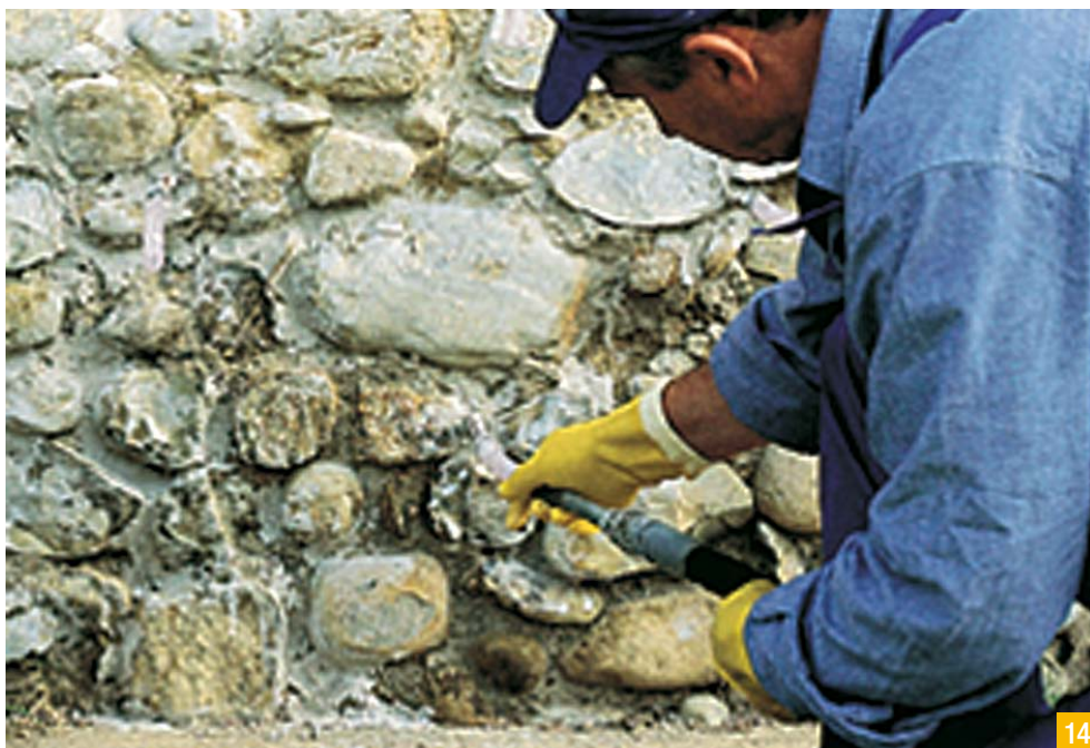
Slika 14: Injektiranje zidu z Mape-Antique.
