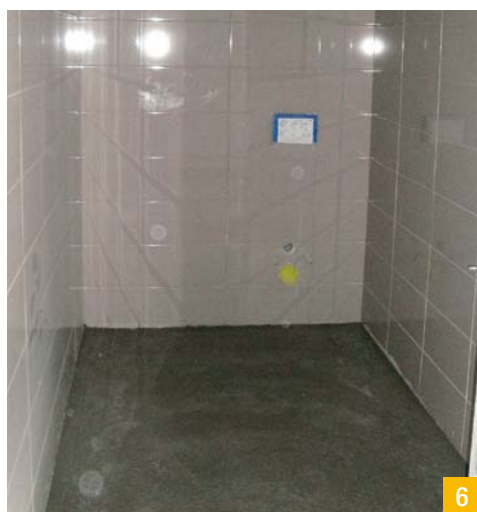
Slika 6: Sanitarije po- slovnega dela – stene so zaključene, na tleh je viden Mapelast.
