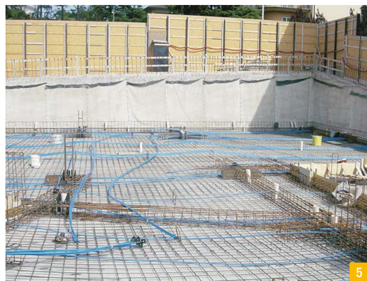
Slika 5: Armiranje plošče z armaturno mrežo.
