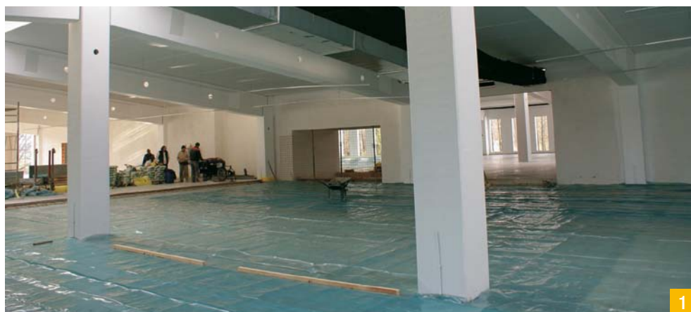
Slika 1: Priprava podlage pred nanašanjem Mapecrete tlaka – PE folija.
