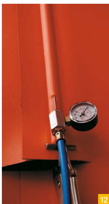
Slika 12: Izvedba tlačnega preskusa dvojnega zvara predorske PVC hidroizolacije.
