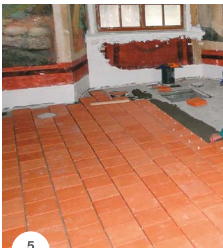
Slika 5: Polaganje zaključne obloge iz opečnih tlakovcev v cementno lepilo KERAFLEX MAXI S1.
