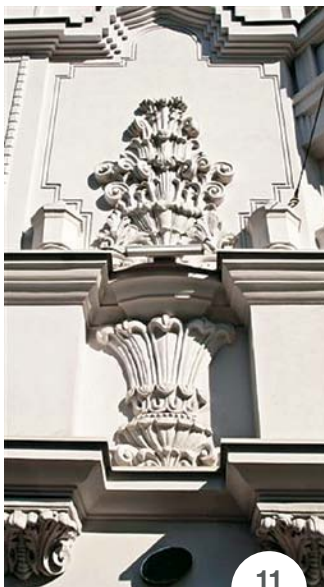
Slike 11-12: Avtentične detajle fasade so pazljivo rekonstruirali. Z uporabo dekorativne barve SILANCOLOR jim je bil vrnjen prvotni videz.
