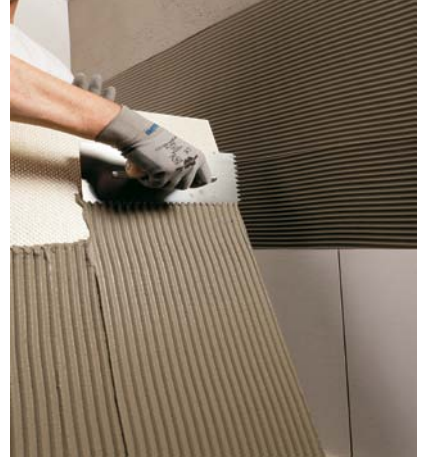
Slika zgoraj: Pravilo pri vgradnji ploščic na zunanjih površinah je obojestranski nanos lepila – nanos na hrbtišče ploščice in na podlago.
