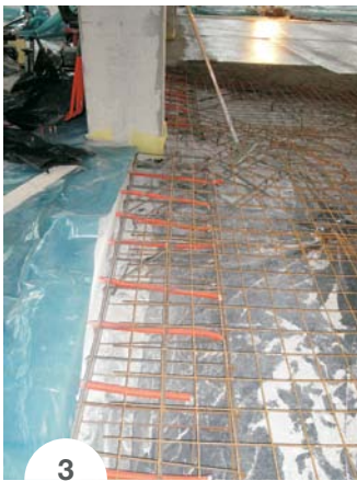
Slika 3: Detajl vgrajevanja betona – primer pravilnega mozničenja na delovnem stiku.
