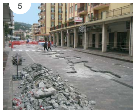
Slika 3: Posledice delovanja izmenjujočih se ciklov zmrzovanja in odtaljevanja.
