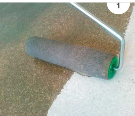
Slika 1: Nanos enokomponentnega poliuretanskega temeljnega premaza ECO PRIM PU 1K.
