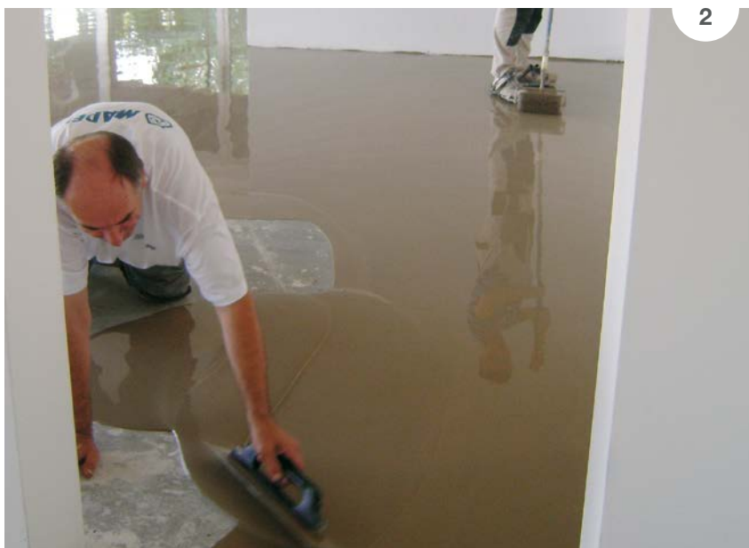
Slika 2: Za reševanje neravnin je Mapei razvil hitro sušeče samorazlivne izravnalne mase.
