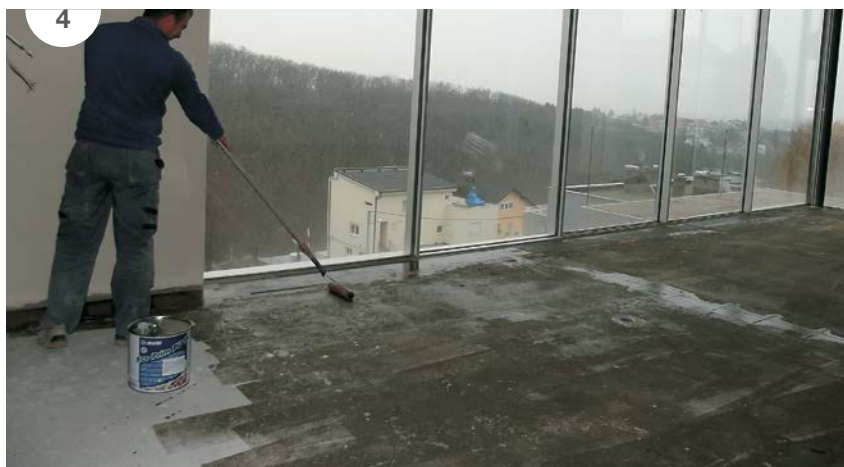
Slika 4: Nanašanje temeljnega premaza ECO PRIM PU 1K.
