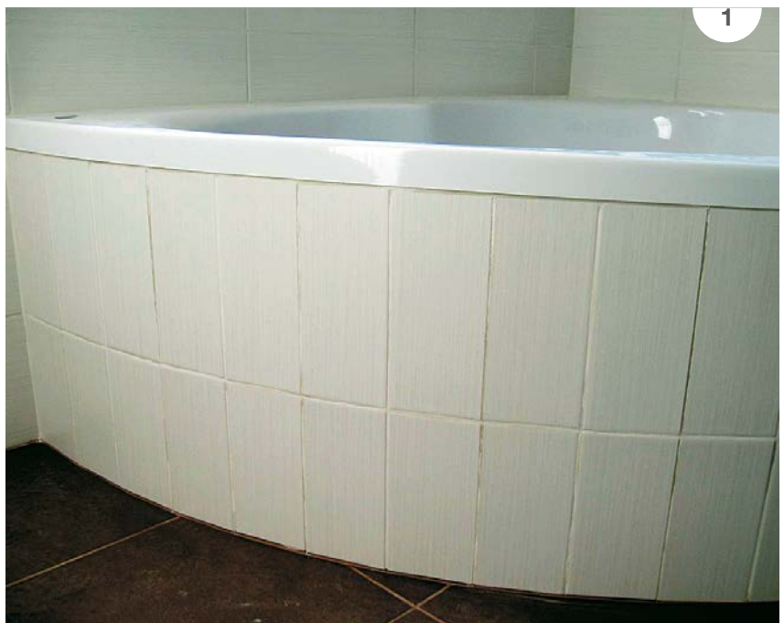
Slika 1: Neenakomeren odtенок vgrajenih fug je posledica neenakomerne in prekomerne zapolnitve fug z lepilom za ploščice.
