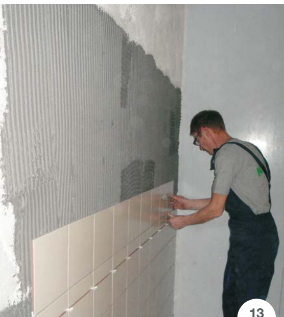
Slika 13: Lepljenje keramičnih ploščic s KERAPOXY ADHESIVE.
