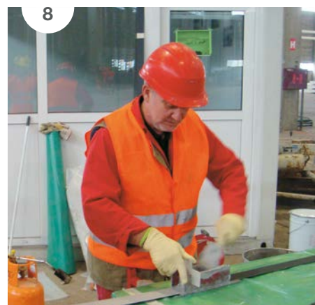
Slika 5: Priprava podlage – sesanje pred nanosom epoksidnega lepila.
