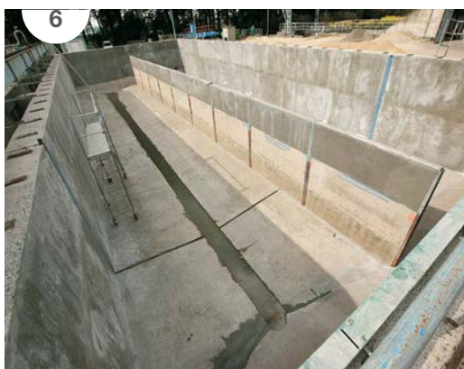
SLIKA 4: Priprava betonske podlage s postopkom peskanja pred nanosom fine sanacijske malte MAPEFINISH in zaščitnega premaza MAPECOAT I 24.
