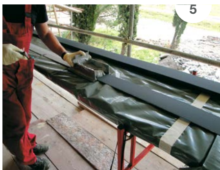
SLIKA 3: Preverjanje podlage pred lepljenjem karbonski lamel CARBOPLATE – izvedba testa pull-off. SLIKI 4 in 5: Nanašanje epoksidnega lepila ADESILEX PG2 na karbonsko lamelo. SLIKA 6: Vgradnja karbonske lamele. SLIKA 7: Pogled na vgrajene lamele CARBOPLATE.
