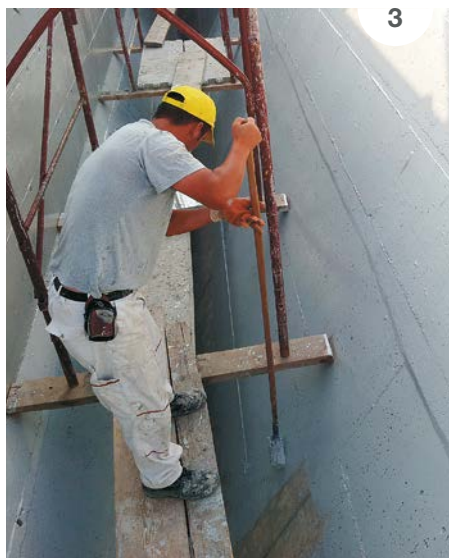
SLIKA 3: Nanos prvega sloja zaključne barve MAPECOAT I 24.
