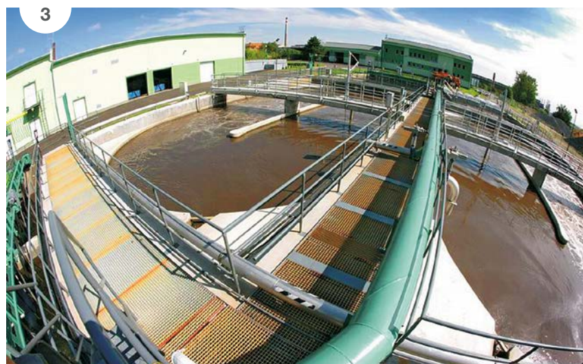
SLIKA 3: Čistina naprava za obdelavo odpadnih voda Hulin na Češkem.
