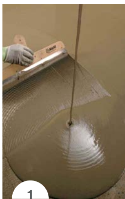
SLIKA 1: Nanos samorazlivne izravnalne mase ULTRAPLAN ECO.
