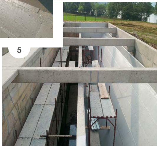
SLIKA 4: Površine armiranobetonskega bazena čistilne naprave, obdelane z dvokomponentno na kislino odporno epoksidno barvo MAPECOAT I 24.
