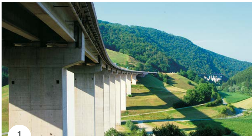
SLIKA 1: Viadukt Škedenj na odseku avtoceste Hoče-Arja vas.
