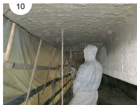
SLIKA 6: Most čez Savo v Podnartu. SLIKA 7: Pogled na obstoječo armaturo po strojni odstranitvi betona z vodo pod pritiskom do 2000 barov. SLIKA 8: Nanašanje antikorozijske malte MAPEFER 1K na armaturo. SLIKA 9: Pogled na premazano armaturo z MAPEFER-jem 1K. SLIKA 10: Strojno nanašanje malte MAPEGROUT T60 (ograja je bila postavljena zaradi nižjih temperatur, zato je bilo potrebno dodatno ogrevanje).
