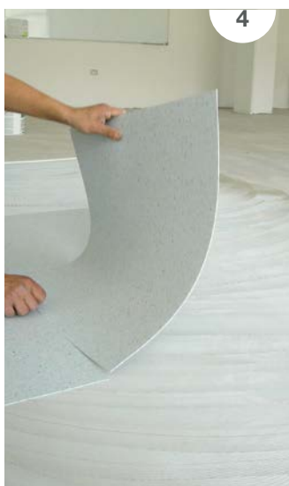
SLIKA 4: Polaganje PVC obloge v ploščah.
