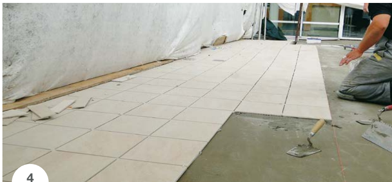
SLIKA 4: Polaganje zaključne obloge iz keramičnih ploščic v cementno lepilo KERAFLEX MAXI S1.
