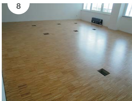
SLIKA 8: Izgled površine po osušitvi temeljnega laka ULTRACOAT PREMIUM BASE.
