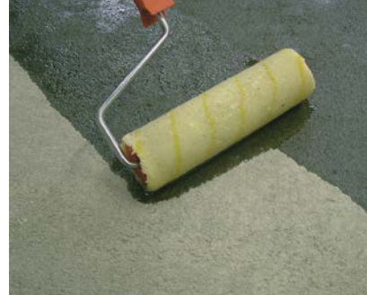
SLIKA ZGORAJ: Izvedba zapore previsoke preostale vlage v cementnem estrihu z ECO PRIM-om PU 1K.
