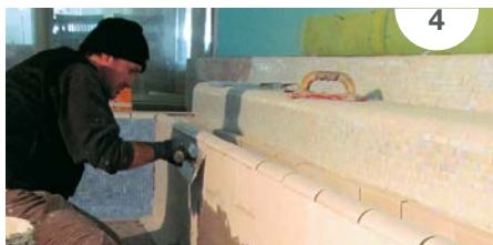
SLIKA 4: Nanašanje lepila ADESILEX P10, pripravljenega z razredčenim ISOLASTIC-om.
