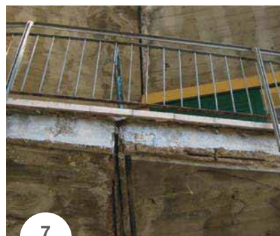
SLIKA 7: Poškodovana konstrukcijska dilatacija.
