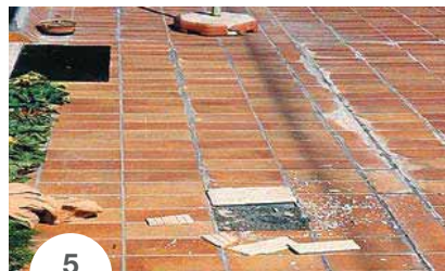
SLIKA 9: Talni odtok s problemom zamakanja.
