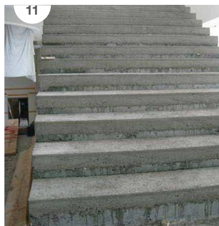
SLIKA 11: Izravnava višin je bila na stopnišču izvedena s hitro sušečim cementnim estrihom TOPCEM PRONTO.
