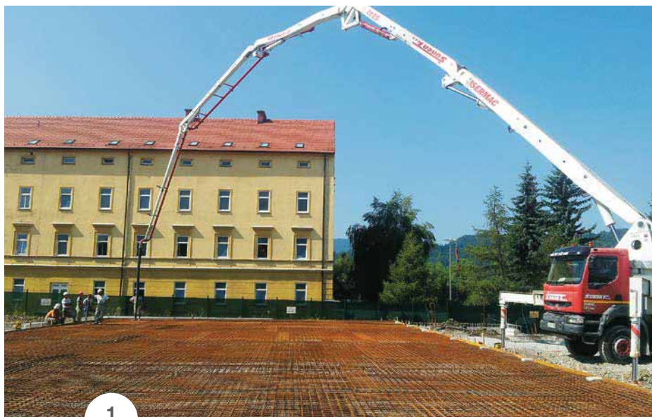
SLIKA 1: Vgradnja betonske mešanice s pomočjo transportne črpalke.
