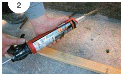
SLIKA 2: Vgradnja moznikov z MAPEFIX-om VE SF.
