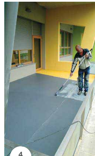
SLIKA 4: Zaključni premazi MAPECOAT TNS FINISH 1 in MAPECOAT TNS COLOR so se na površino nanašali z valjčkom.
