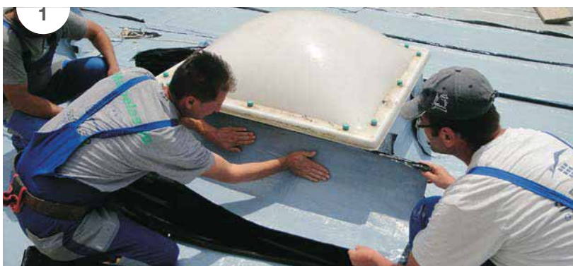
SLIKA 1: Lepljenje parne zapore POLYVAP SA okoli kupole.
