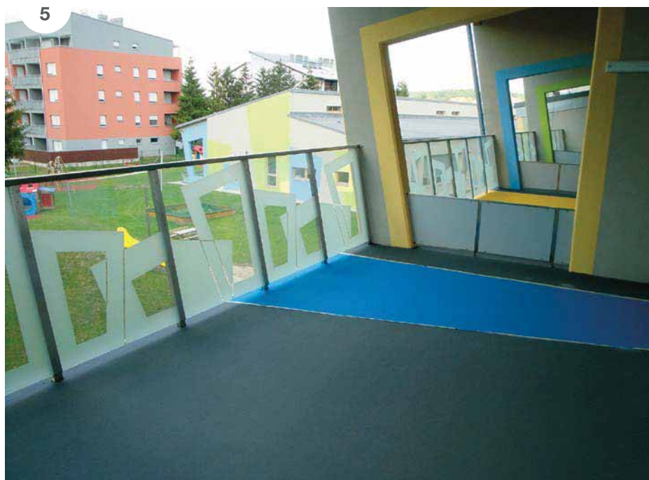
SLIKA 5: Kar 20 različnih barvnih vzorcev, zaključnih premazov sistema Mapecoat TNS, omogoča, da talna obloga smiselno zaključuje celotno podobo objekta.
