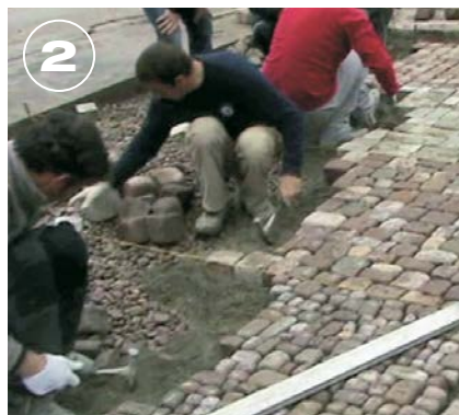
SLIKA 1: Detalj priprave podlage – utrjevanje nasutja.
