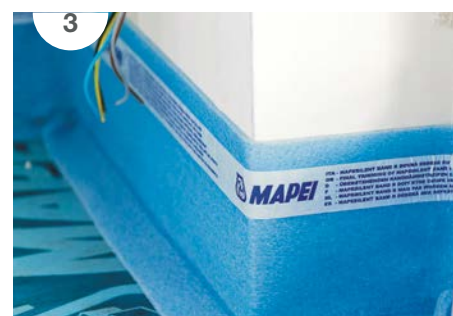
SLIKA 1: Na beton so položili zvočno izolacijo v rolah MAPESILENT ROLL, in sicer s filcem navzdol. Da bi se izognili morebitnim zvočnim mostovom, so izolacijo polagali s 5-centimetrskimi preklopi.
