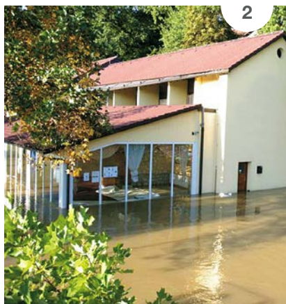
SLIKA 3: Tipične poškodbe notranjosti zidanega gradbenega objekta po poplavi.
