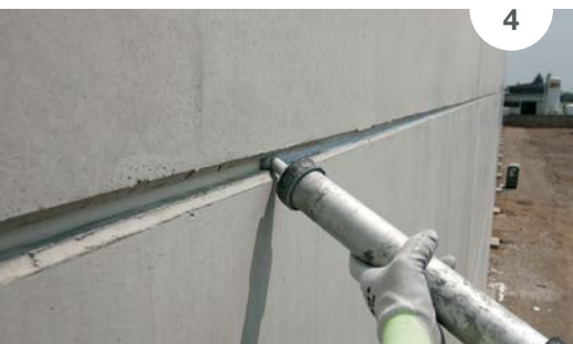
SLIKA 4: Tesnjenje dilatacije med dvema AB-fasadnima elementoma.
