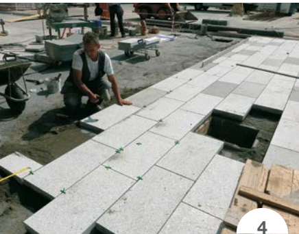
SLIKA 4: Polaganje kamna na gosto polimerno cementno polivko (PLANICRETE), ki je bila ulita na svežo, primerno skomprimirano in na ustrezno višino poravnano malto MAPESTONE TFB 60. Vsak kamen je bilo treba utrditi z gumiranim kladivom oz. batom.
