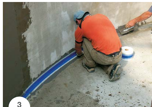
SLIKA 3: Vgradnja MAPEBAND tesnilnega traku z MAPELASTIC-om v bazenu.
