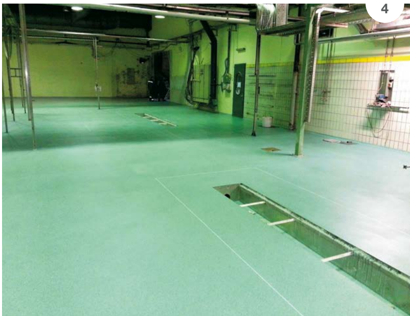
SLIKA 4: Končni videz epoksidnega tlaka pred vgradnjo tehnološke opreme.
