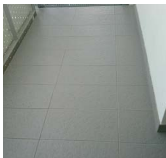
SLIKA 1: Za lepljenje zaključne obloge iz keramičnih ploščic je bilo uporabljeno visoko zmogljivo, prilagodljivo cementno lepilo KERAFLEX MAXI S1.
