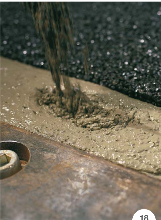
SLIKA 18: Zalivanje dilatacijskega profila z MAPEGROUT COLABILE TI 20 + FIBRE R60.
