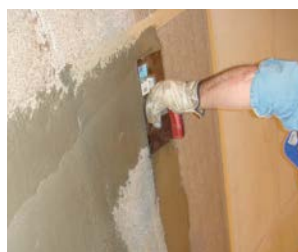
SLIKA 3: Zaščita betonskih sten tunela Markovec z namensko dvo-komponentno epoksidno barvo s "keramičnim" izgledom MAPECOAT I 650 WT. Ta nudi potrebno zaščito pred prodiranjem škodljivih snovi in ustrezno refleksivnost površine, s tem boljše vidljivost in večjo varnost v tunelu.
