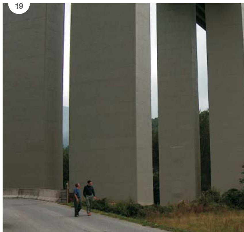
SLIKA 19: Primer dekorativne zaščite zgladitvenega sloja MAPELASTIC-a z visoko elastično barvo ELASTOCOLOR PITTURA.
