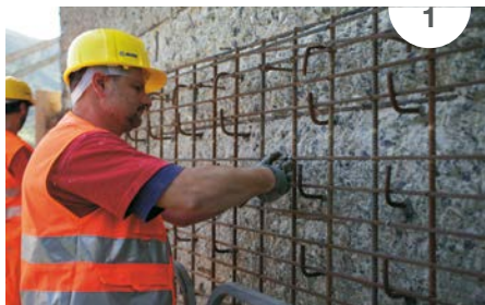
SLIKA 1: Nameščanje nove armature na ustrezno pripravljeno površino z vgrajenimi sidri.
