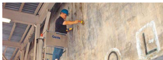
SLIKA 2: Viadukt Škedenj na odseku avtoceste Hoče–Arja vas. Ko je bila armatura očiščena do kovinskega sijaja, je sledil nanos (v dveh slojih) MAPEFER-ja 1K, protikorozijske malte na osnovi cementnega veziva, polimerov in korozijskih inhibitorjev. Odstranjeni beton se je nadomestil z nanosom sulfatno odporne mikroarmirane sanacijske malte MAPEGROUT T60.
