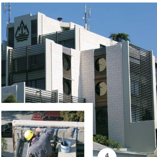
SLIKA 4: Betonska fasada Splošne plovbe – po ročnem odstranjevanju betona okoli poškodovane armature ter čiščenju s kombinacijo strojnega in ročnega dela je sledil dvakratni premaz armature z MAPEFER-jem, manjkajoče betone so nadomestili z MAPEGROUT-om T40. Po zorenju je sledilo pranje celotne površine, ta se je zaključno preplastila z MONOFINISH-em. Sledil je še zaključni zaščitno-dekorativni sistem Elastocolor.
