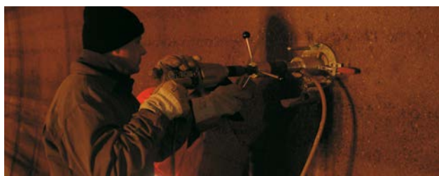
SLIKA 3: Zaščita betonskih sten tunela Markovec z namensko dvo-komponentno epoksidno barvo s "keramičnim" izgledom MAPECOAT I 650 WT. Ta nudi potrebno zaščito pred prodiranjem škodljivih snovi in ustrezno refleksivnost površine, s tem boljše vidljivost in večjo varnost v tunelu.
