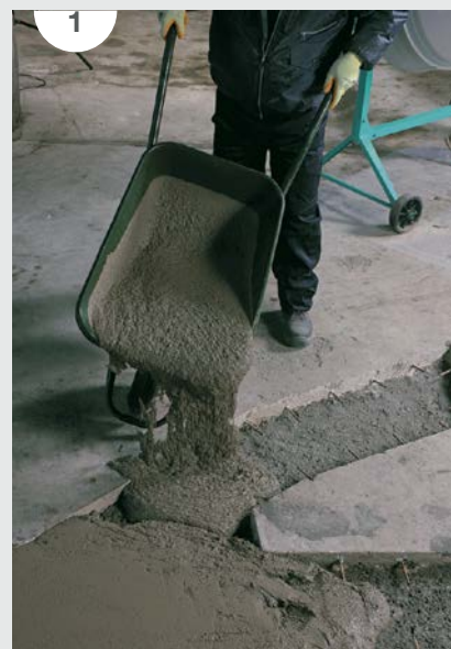
SLIKA 1: Vgradnja na gradbišču pripravljene- ga betona z dodatkom za zimsko izvedbo – MAPEFAST CF/L.
