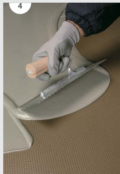
SLIKA 2: Vgradnja hitro vezoče malte PLANITOP RASA & RIPARA je možna pri temperaturah, višjih od 5\text{ }^{\circ}\text{C} .
