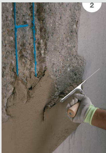
SLIKA 2: Vgradnja hitro vezoče malte PLANITOP RASA & RIPARA je možna pri temperaturah, višjih od 5\text{ }^{\circ}\text{C} .
