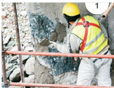
SLIKA 2: Injektiranje razpok v betonskih stebrih z namensko, redko tekočo epoksidno smolo EPOJET.
