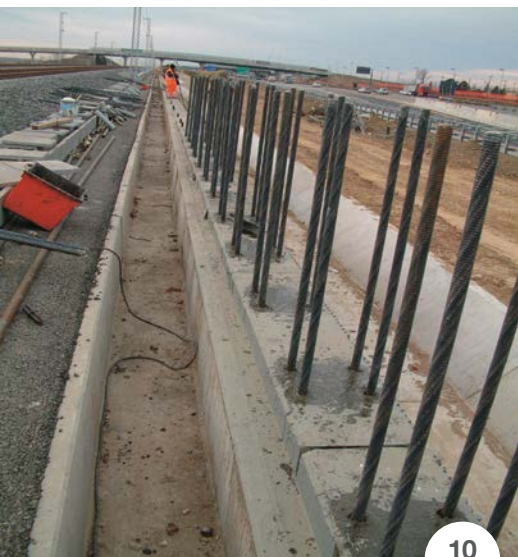
SLIKA 10: Sidranje armaturnih palic v betonski parapetni zid z uporabo PLANIGROUT 300.
