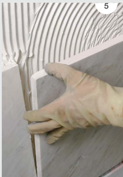
SLIKA 5: Lepljenje občutljivega kamna s KERALASTIC-om T mora biti izvedeno pri temperaturah, višjih od 10 stopinj C.
