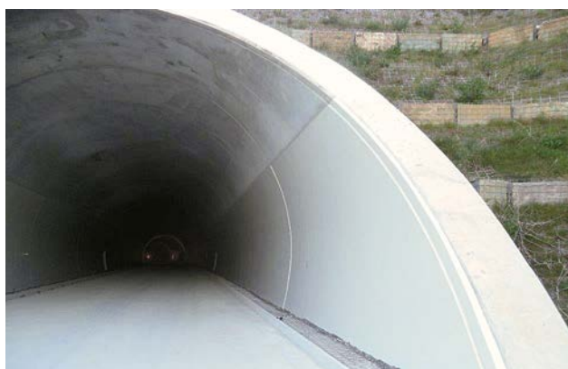
SLIKA 3: Zaščita betonskih sten tunela Markovec z namensko dvo-komponentno epoksidno barvo s "keramičnim" izgledom MAPECOAT I 650 WT. Ta nudi potrebno zaščito pred prodiranjem škodljivih snovi in ustrezno refleksivnost površine, s tem boljše vidljivost in večjo varnost v tunelu.
