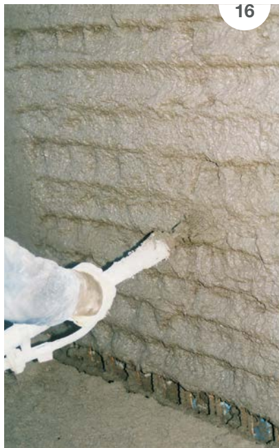
SLIKA 17: Primer uporabe MAPEGROUT-a SV.
