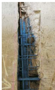
SLIKA 1: Muzej Guggenheim v New Yorku. Po natančno izvedeni analizi poškodovanih površin in razpok ameriškega raziskovalnega inštituta sta se izvedla mehansko odstranjevanje in čiščenje površin. Lokalna obnovitvena dela na mestih korodirane armature z namenom dolgotrajne zaščite pred nadaljnjim procesom propadanja so se izvedla z MAPEFER-jem 1K, za tem so bila poškodovana mesta betona popravljena z izdelki iz družine PLANITOP.
