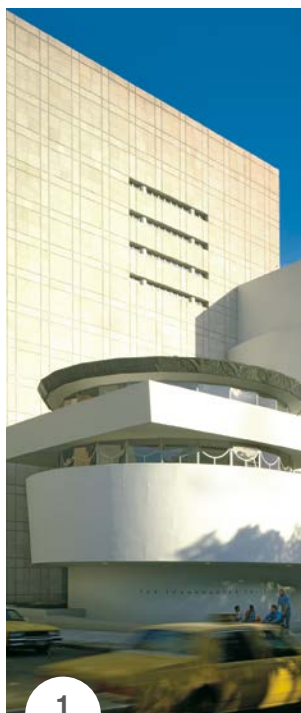
SLIKA 1: Muzej Guggenheim v New Yorku. Po natančno izvedeni analizi poškodovanih površin in razpok ameriškega raziskovalnega inštituta sta se izvedla mehansko odstranjevanje in čiščenje površin. Lokalna obnovitvena dela na mestih korodirane armature z namenom dolgotrajne zaščite pred nadaljnjim procesom propadanja so se izvedla z MAPEFER-jem 1K, za tem so bila poškodovana mesta betona popravljena z izdelki iz družine PLANITOP.
