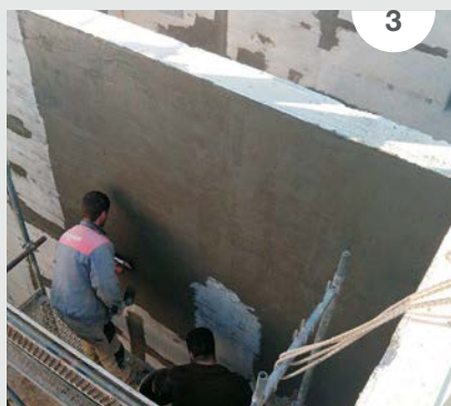
SLIKA 2: Vgradnja hitro vezoče malte PLANITOP RASA & RIPARA je možna pri temperaturah, višjih od 5\text{ }^{\circ}\text{C} .
