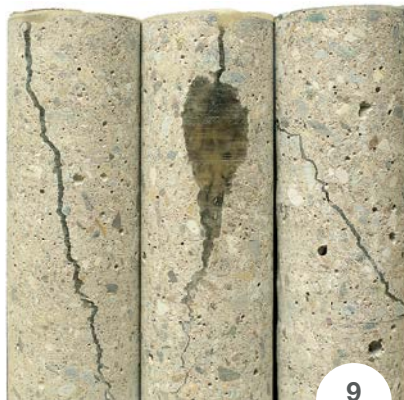
SLIKA 9: Izvrtini valj betona po opravljenem injektiranju z EPOJET-om.
