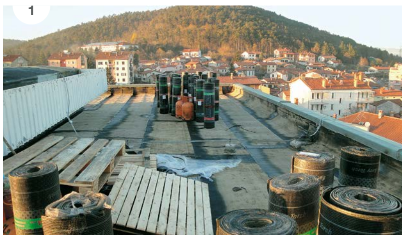
SLIKA 1: PLANA P MINERAL na strehi pred vgradnjo.
