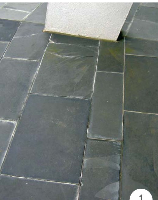
SLIKA 1: Izcvetanje kalcijevega karbonata na fugah oblog iz skrilavca kot posledica polaganja v neprimeren sistem malte.
