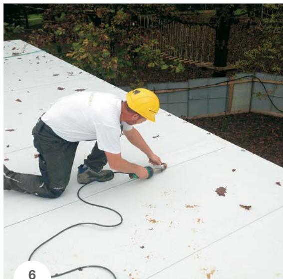
SLIKA 3: Površina bazena, pripravljena za nadgradnjo z zaključno oblogo iz keramičnih ploščic. SLIKA 4: Priprava podlage s hitro vezočo, mikroarmirano cementno malto PLANITOP FAST 330 pred polaganjem zaključne obloge iz keramičnih ploščic. SLIKA 5: Polaganje zaključne obloge v bazenu iz keramičnih ploščic. SLIKA 6: Ročno varjenje stikov hidroizolacijske folije MAPEPLAN M z namenskim fenom z vročim zrakom.
