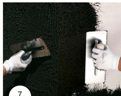
SLIKA 5: Nanašanje izdelka iz linije Plastimul z gladilko na betonsko steno.
