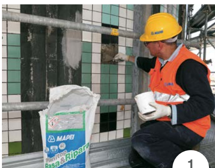
SLIKA 1: Betonsko podlago so obnovili z malto PLANITOP RASA&RIPARA.
