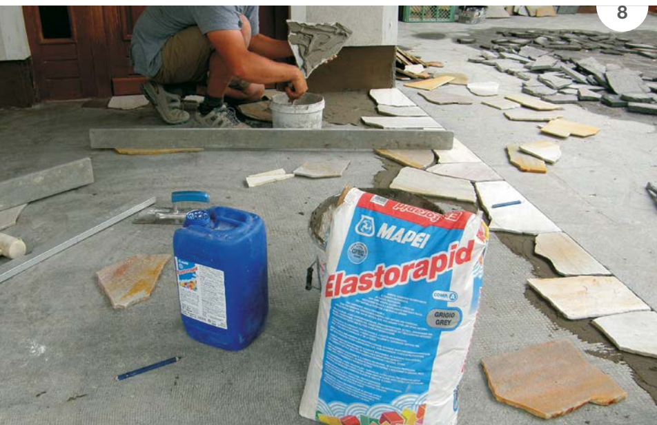
SLIKA 8: Lepljenje tankih plošč rumenega kvarcita s hitro vezočim lepilom ELASTORAPID, ki ima hkrati podaljšan odprti čas.
