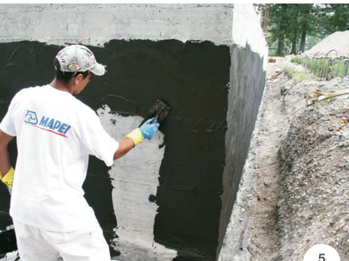
SLIKA 5: Nanašanje izdelka iz linije Plastimul z gladilko na betonsko steno.
