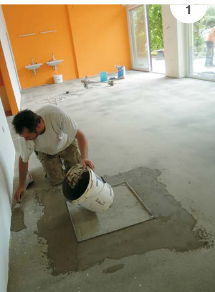
SLIKI 1 in 2: Za pripravo in grobo niveliranje podlage je bila uporabljena hitro vezoča cementna izravnalna malta NIVORAPID.
