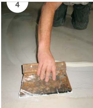
SLIKA 4: Nanos lepila ULTRABOND 333 pred polaganjem zaključne obloge.
