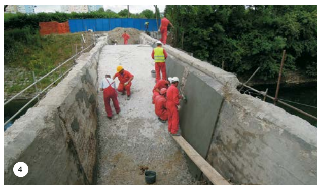
SLIKI 2 in 3: Nanos MAPEFER-ja 1K na spodnjem delu loka. SLIKA 4: Nanašanje malte MAPEGROUT T60 na notranji del loka. SLIKA 5: Nanašanje in zaključna obdelava s sanacijsko malto MAPEGROUT 430 na zunanji strani loka. SLIKA 6: Nanašanje malte MAPEGROUT 430 kot fino zapolnitev/izravnavo po vgradnji CARBOPLATE karbonskih lamel.
