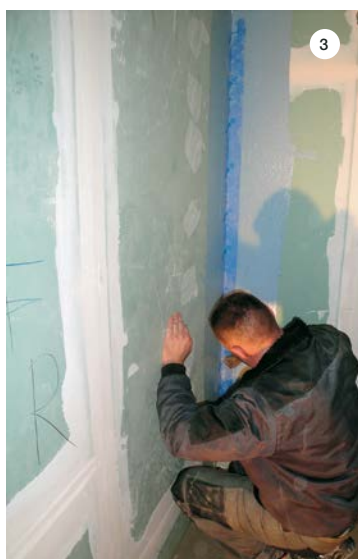
SLIKA 3: Vgradnja MAPEGUARD ST v MAPELASTIC AQUADEFENSE.
