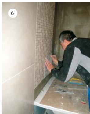
SLIKA 7: Pogled na steno kopalnice, fugirane s KERACOLOR FF, dilatacijski stiki tesnjeni z MAPESIL AC pred pleskarskimi deli in fino montažo opreme.
