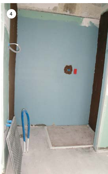
SLIKA 3: Vgradnja MAPEGUARD ST v MAPELASTIC AQUADEFENSE.
