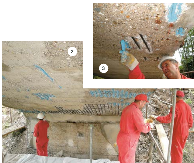
SLIKI 2 in 3: Nanos MAPEFER-ja 1K na spodnjem delu loka. SLIKA 4: Nanašanje malte MAPEGROUT T60 na notranji del loka. SLIKA 5: Nanašanje in zaključna obdelava s sanacijsko malto MAPEGROUT 430 na zunanji strani loka. SLIKA 6: Nanašanje malte MAPEGROUT 430 kot fino zapolnitev/izravnavo po vgradnji CARBOPLATE karbonskih lamel.
