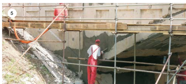
SLIKI 2 in 3: Nanos MAPEFER-ja 1K na spodnjem delu loka. SLIKA 4: Nanašanje malte MAPEGROUT T60 na notranji del loka. SLIKA 5: Nanašanje in zaključna obdelava s sanacijsko malto MAPEGROUT 430 na zunanji strani loka. SLIKA 6: Nanašanje malte MAPEGROUT 430 kot fino zapolnitev/izravnavo po vgradnji CARBOPLATE karbonskih lamel.
