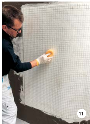
SLIKA 9, 10 in 11: Fugiranje v bazenu s KERAPOXY DESIGN in čiščenje.
