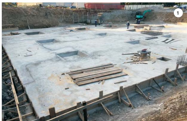
SLIKA 1: Temeljna plošča pred izolacijo.
