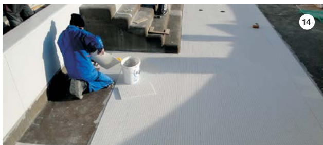
SLIKA 13: Nanašanje MAPELASTIC TURBO na terasi.
