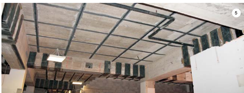
SLIKA 5: Vgrajena tkanina MAPEWRAP in lamele CARBOPLATE.
