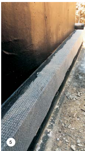
SLIKA 5: Detajl stika bitumske hidroizolacije PLASTIMUL 2K REACTIVE in bentonitne geotkanine MAPEPROOF LW. Na stiku je vgrajen dodaten sloj bentonitne geotkanine MAPEPROOF LW, zatesnjen z bentonito pasto MAPEPROOF MASTIC.
