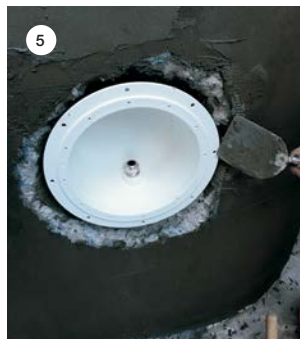
SLIKA 4: Vidna je zaščita armature z MAPEFER 1K. SLIKA 5: Pritrditev reflektorja z MAPEGROUT T60.
