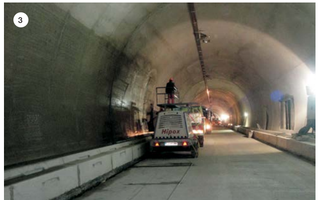
SLIKA 1: Nanos PRIMER-a AS na element. SLIKA 2: Nanos MAPEFLEX-a PU45. SLIKA 3: Pranje z vodo pod visokim pritiskom.
