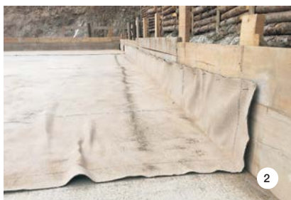
SLIKA 2 in 3: Enostavno vgrajevanje bentonitne geotkanine Mapeproof LW, tudi na razgibanih površinah.
