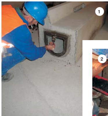
SLIKA 1: Nanos PRIMER-a AS na element. SLIKA 2: Nanos MAPEFLEX-a PU45. SLIKA 3: Pranje z vodo pod visokim pritiskom.
