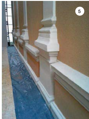
SLIKE 5, 6 in 7: Stena med starim in novim delom Narodne galerije pred izvedbo, po odstranitvi ometa in že izvedenim vodilom (t. i. faže) iz MAPE-ANTIQUE STRUTTURALE NHL.
