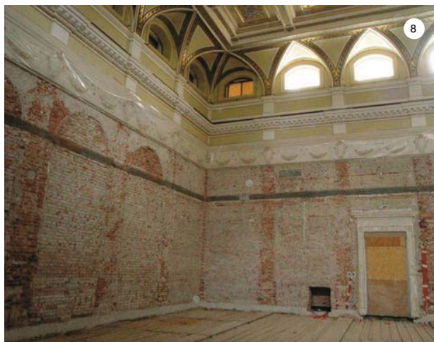
SLIKA 8: Pogled na osrednjo dvorano po odstranitvi ometov.
