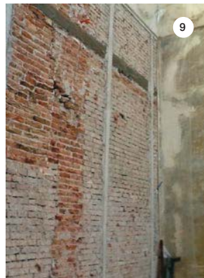
SLIKI 9 in 10: Izvedena vodila iz MAPE-ANTIQUE STRUTTURALE NHL. Izvedba povezav v osrednji dvorani z MAPEWRAP B FIOCCO.
