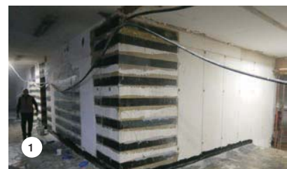
SLIKA 1: Ojačitev vogalnega AB-elementa s trakovi MAPEWRAP.
