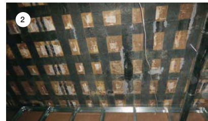
SLIKA 2: Strop po izvedeni dvosmerni ojačitvi pod pravim kotom.
