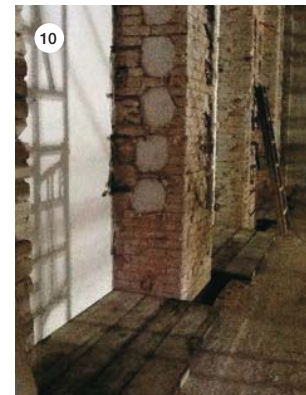
SLIKI 9 in 10: Izvedena vodila iz MAPE-ANTIQUE STRUTTURALE NHL. Izvedba povezav v osrednji dvorani z MAPEWRAP B FIOCCO.
