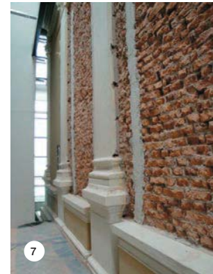
SLIKE 5, 6 in 7: Stena med starim in novim delom Narodne galerije pred izvedbo, po odstranitvi ometa in že izvedenim vodilom (t. i. faže) iz MAPE-ANTIQUE STRUTTURALE NHL.
