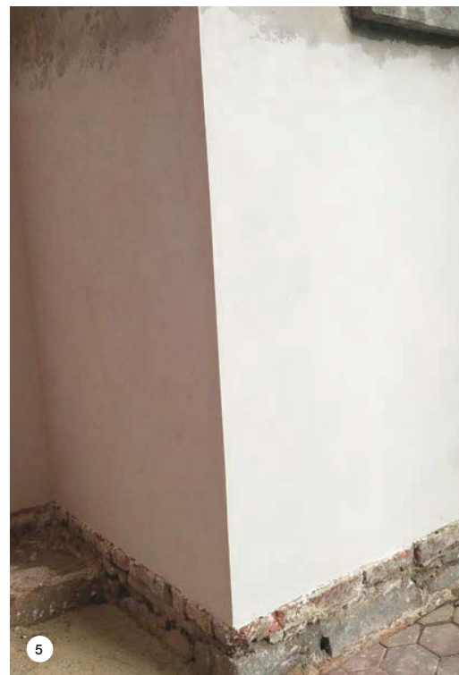
SLIKE 5 in 6: Videz pročelja po izvedenih izsuševalnih ometih pred barvanjem z zaključno dekorativno visoko prepustno silikatno barvo SILEXCOLOR.
