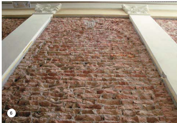
SLIKE 5, 6 in 7: Stena med starim in novim delom Narodne galerije pred izvedbo, po odstranitvi ometa in že izvedenim vodilom (t. i. faže) iz MAPE-ANTIQUE STRUTTURALE NHL.
