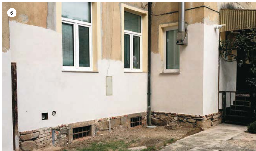
SLIKE 5 in 6: Videz pročelja po izvedenih izsuševalnih ometih pred barvanjem z zaključno dekorativno visoko prepustno silikatno barvo SILEXCOLOR.
