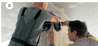
SLIKA 3: Nanašanje lepila na steber in ploščico.
