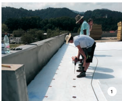
SLIKA 1: Pogled na streho med izvedbo.
