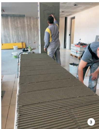
SLIKA 3: Nanašanje lepila na steber in ploščico.
