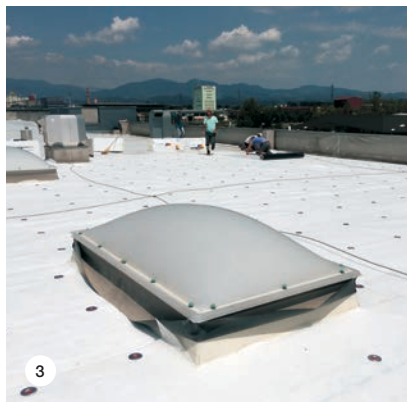
SLIKA 2: Montaža indukcijskih nastavkov/podložk in varjenje spojev s toplim zrakom z Leister Varimat V2.
