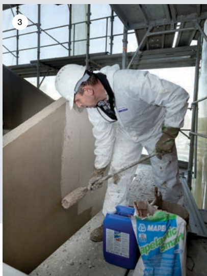
SLIKA 4: MAPELASTIC TURBO je idealen za izvedbo tesnjenj v pomladanskih in jesenskih mesecih.
