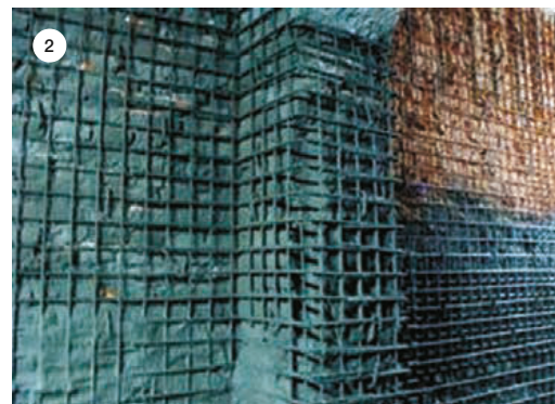
SLIKA 3: Ojačitev zidanih objektov / objektov naravne in kulturne dediščine s kompozitnim sistemom armaturne mreže iz alkalno odpornih bazaltnih ali steklenih vlaken in visoko duktilne, mikroarmirane malte brez vsebnosti cementa.
