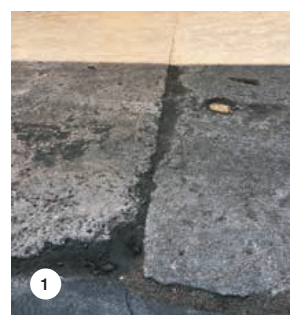
SLIKA 3: Most po izvedeni obnovi s sanacijsko malto MAPEGROUT EASY FLOW GF.
