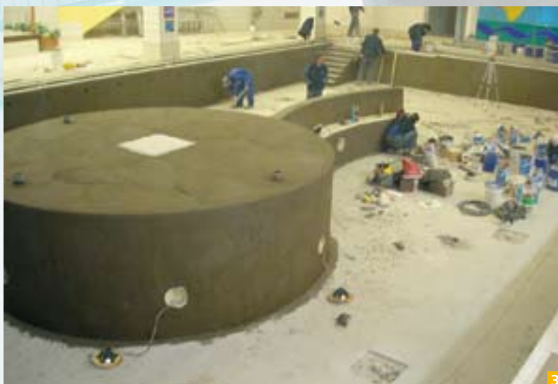
Slika 1: Obnovljeni prelivni rob s tesnilno malto MAPELASTIC in vgrajenim MAPEBAND trakom in manšetami na prebojih in vgradnih elementih
