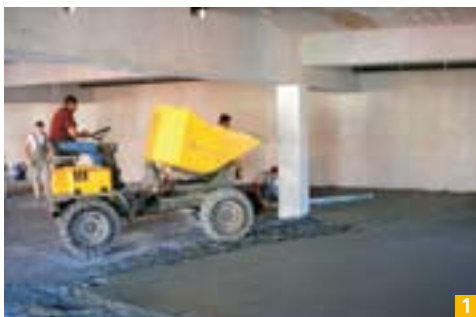
Slika 1: Vgradnja betonske mešanice pripravljene s kemijskimi dodatki po sistemu MAPECRETE na sveži vezni sloj
