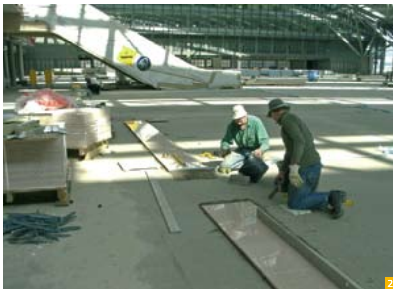
Slika 1: Tla iz granitnih plošč Salisbury Pink v prostorih za prijavo (»check-in«) v novem terminalu 1 letališča v Hamburgu Slika 2: Izvajanje talne obloge v prostorih za »check-in«. Plošče formata 60 x 60 x 3 cm so bile položene z lepilom MAPESTONE 1
