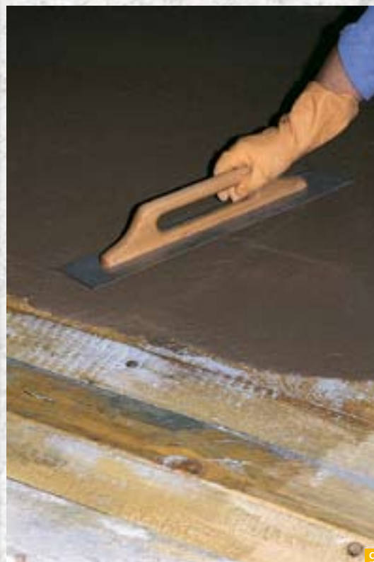
Slika 8: Strojni nanos samorazlivne mase za izravnavanje ULTRAPLAN in zaključna obdelava površine z lopatico
