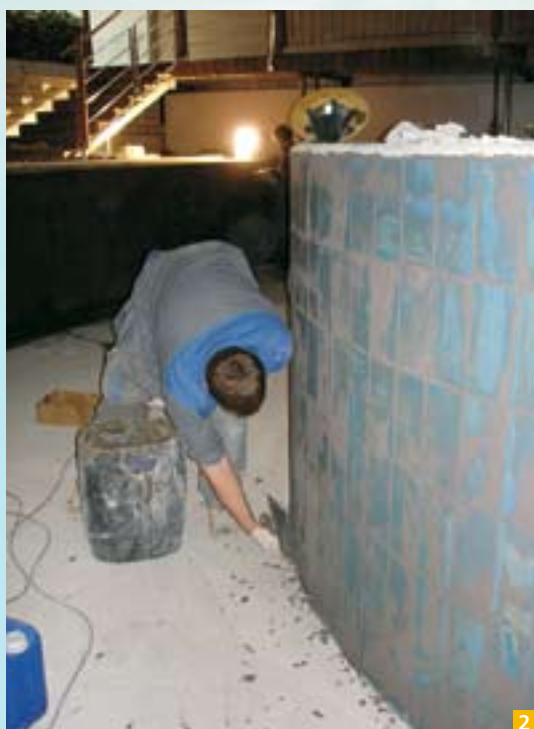
Slika 4: Lepljenje keramičnih ploščic v bazenu z lepilom GRANIRAPID in zafugirano s fugirno maso KERACOLOR GG izboljšano s FUGOLASTIC-om
