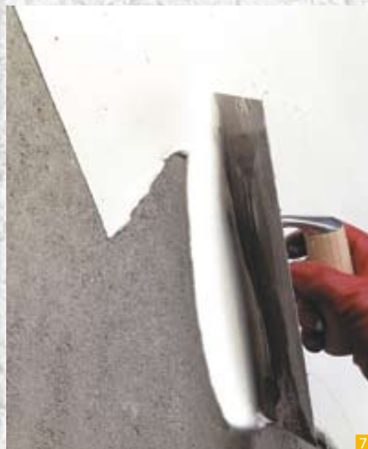
Slika 7: Ročni nanos stenske mase za glajenje PLANITEX A na zidni omet
