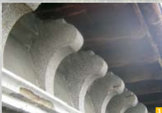
Slika 1: Vidne poškodbe AB balkonske plošče
