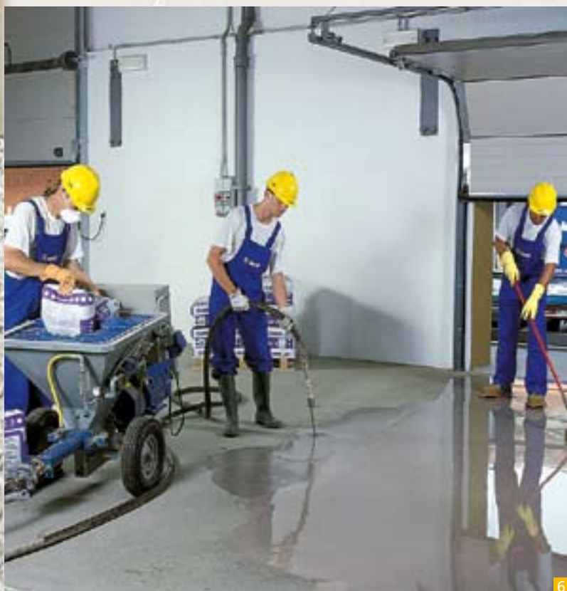
Slika 6: Strojni nanos samorazlivne mase za glajenje NOVOPLAN 21 in zaključna obdelava površine z bodičastim valjčkom
