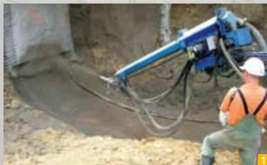
Slika 1: Cenkova – brizganje betona – utrjevanje hribine
