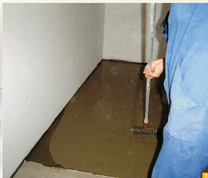
Slika 1: Priprava temeljnega sprijemnega premaza Nivorapid + Latex Plus
