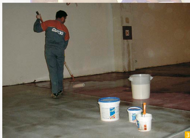
Slika 3: Nanašanje zaščitnega zaključnega premaza Mapecoat I 600 W
