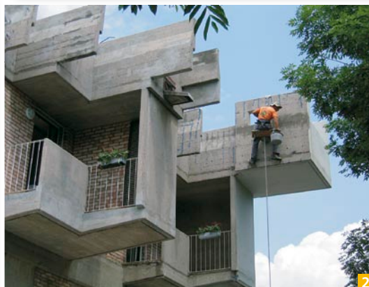
Slika 3: Grob nanos malte izveden s sanacijsko malto Mapegrout T40 ter celotna površina preplastena s fino malto Monofinish
