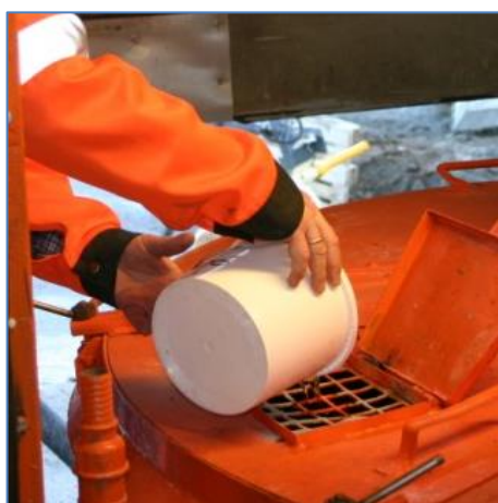
Tillsatsmedel blandas in i betongen.
