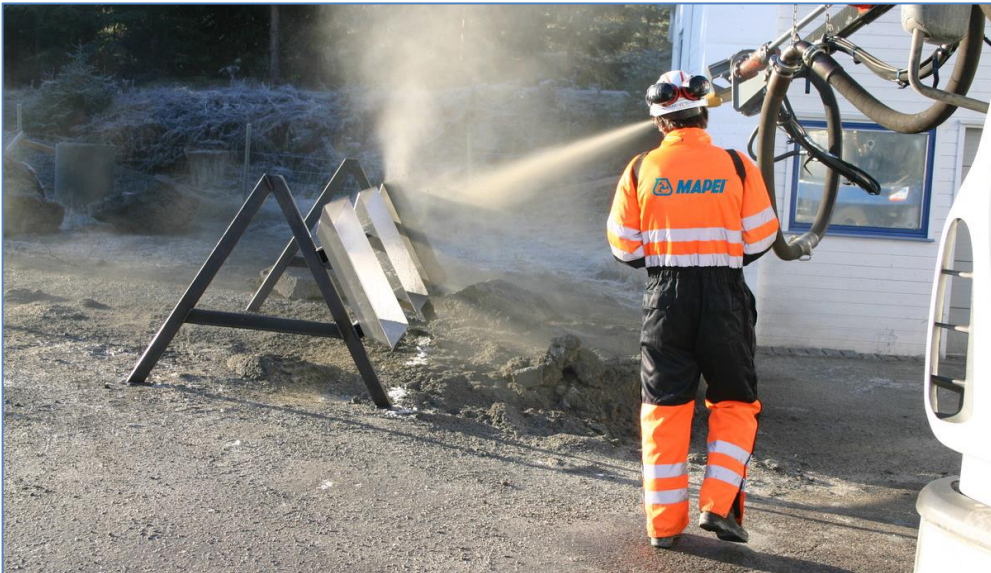
Här tillverkas testprover av sprutbetong.
