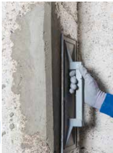
Putsning av ytor försedda med Planitop Smooth & Repair R4 för att skapa en jämn yta
