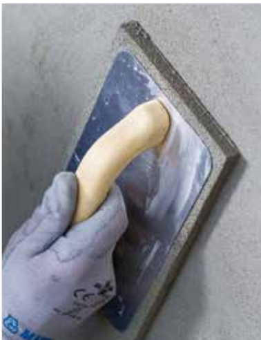
Utjämning av ytor med Planitop Smooth & Repair R4
