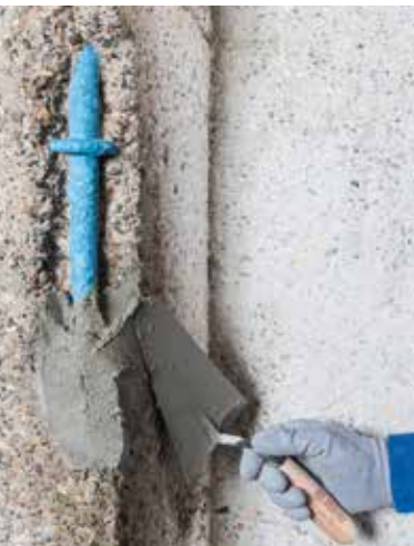
Applicering av Planitop Smooth & Repair R4 med murslev
