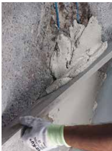
Utjämning av Planitop Smooth & Repair med en rak kant
