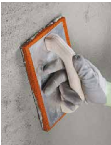
Putsning av ytan på Planitop Smooth & Repair
