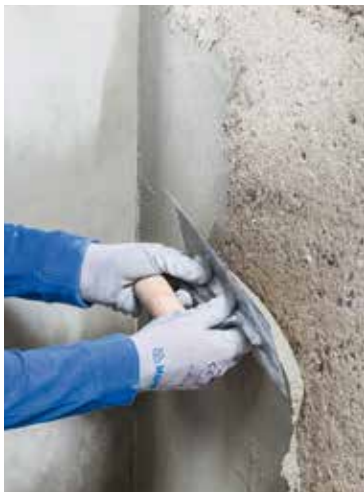
Applicering av Planitop Smooth & Repair R4 med putsbräda
