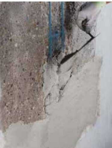
Applicering av Planitop Smooth & Repair med hjälp av murslev
