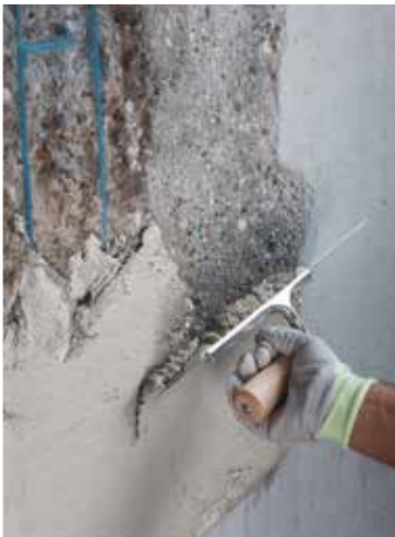
Applicering av Planitop Smooth & Repair med hjälp av putslev
