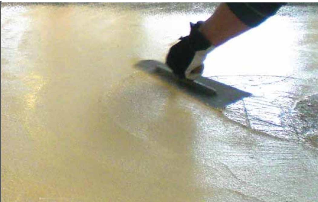
Utläggning av indikatorskikt.
