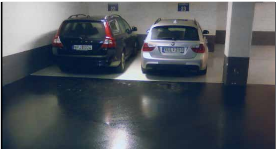
Interiör från Teatergaraget i Malmö, Mapefloor PU system.
