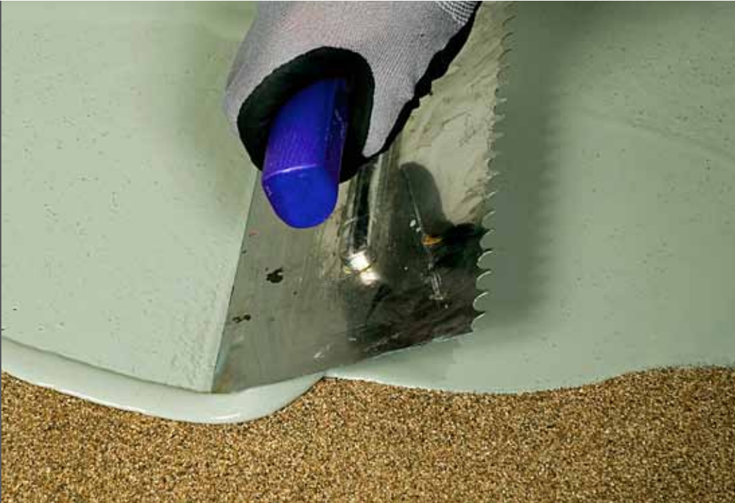
Utläggning av spricköverbyggande membran.
