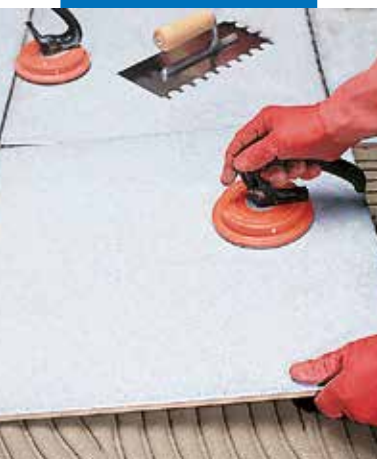
Läggning av stora plattor
