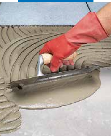
Applicering med semi-cirkulär tandspackel
