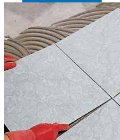
Sättning av porslinsplattor
