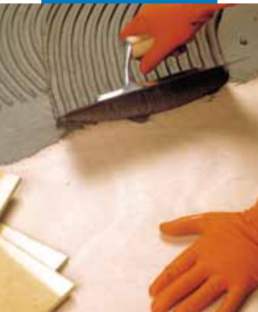
Sättning av porslinsplattor med Elastorapid på ett underlag av marin plywood
