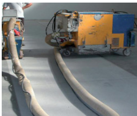
Förberedning av underlaget genom stålsandsblästring
