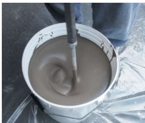
Förberedning av produkten med borrhvisp
