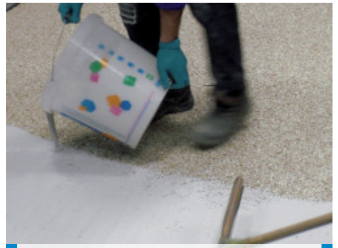
Applisering av Ultratop på det härdade underlaget av naturligt tillslag och Mapefloor I 910
