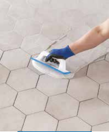
Fogning med Keracolor FF med fogbrätt
