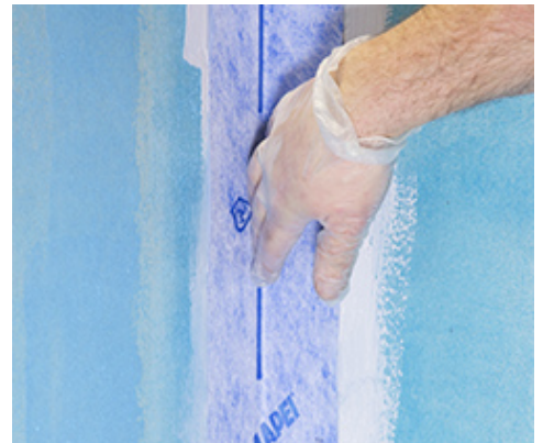
Montering av Mapei ST tätningstejp med Mapegum WPS, vägg
