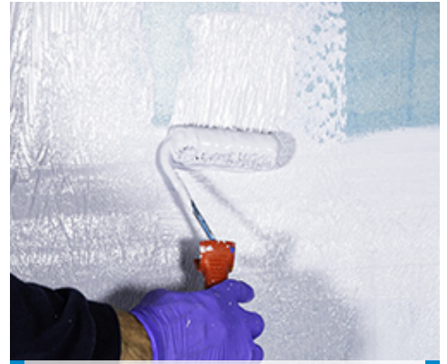
Applicera Mapegum WPS membran med t.ex. en roller
