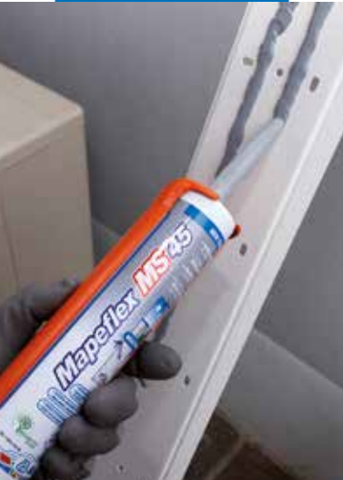
Fastsättning av plastprofiler på en yta utomhus
