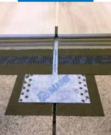
Mapeband Easy som läggs runt en expansionsfog i golvet
