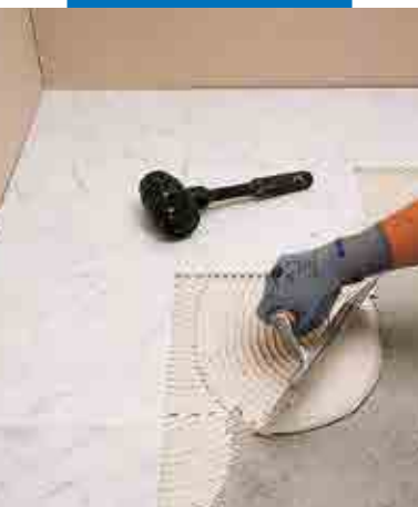
Läggning av vit Carraramarmor med Keraquick S1 vit
