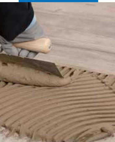
Fastsättning av golvplattor med träimitation
