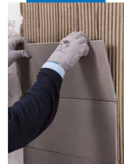
Fastsättning av golvplattor i granitkeramik på lodrät vägg
