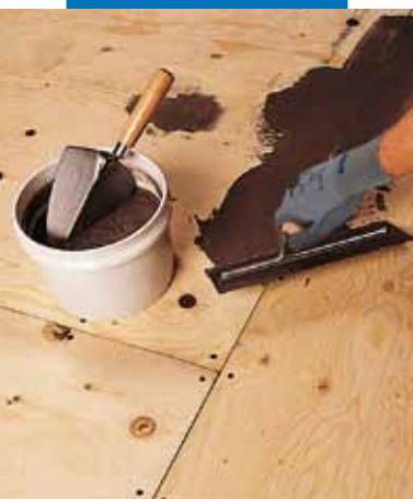
Fogning av plywoodunderlag med Nivorapid + Latex Plus
