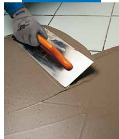
Avjämning av befintligt golv med Nivorapid
