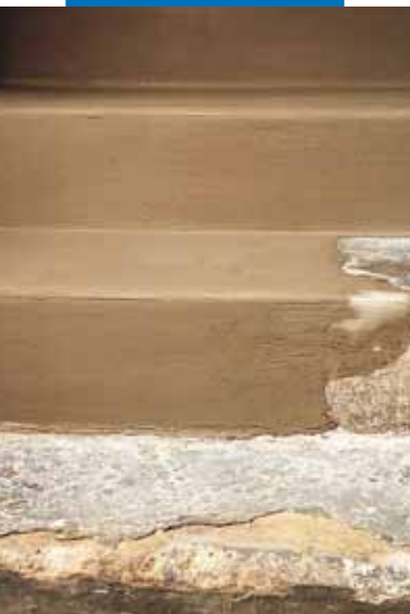
Trappsteg före och efter behandling med Nivorapid
