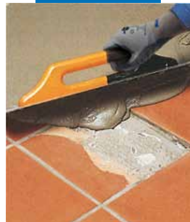
Fyllning av hål med Nivorapid
