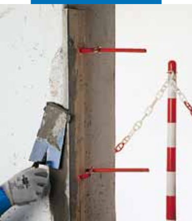
Reparation av vertikalt skarpt hörn med Nivorapid
