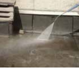
Alt yüzeyin temizlenmesi
