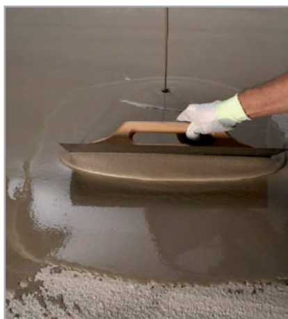
Рис. 8.14. Створення плоскої поверхні стяжки, шляхом нанесення шару ULTRAPLAN ECO
