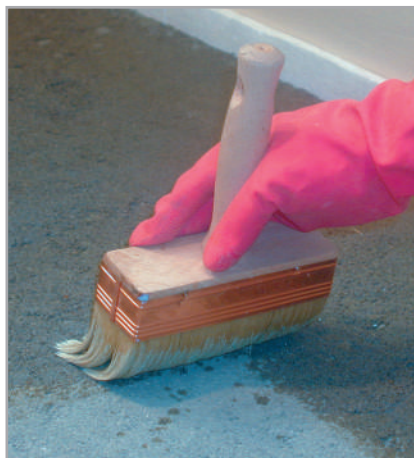
Рис. 8.13. Нанесення щіткою розведеного водою PRIMER G на поверхню стяжки
