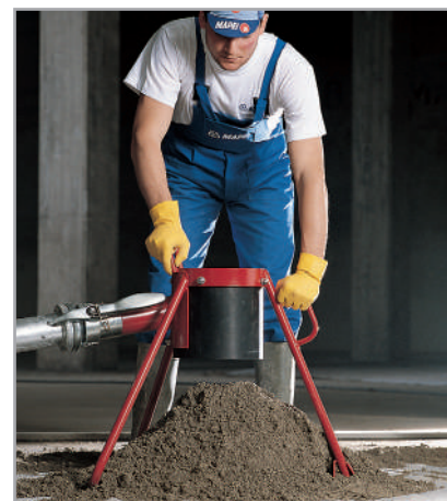
Рис. 6.2. Приготування суміші TOPCEM/TOPCEM PRONTO
