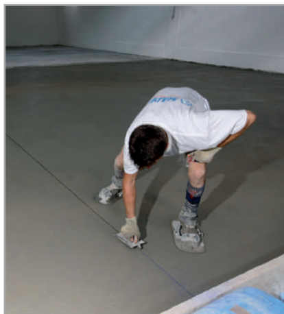
Рис. 7.8. Формування деформаційних швів
