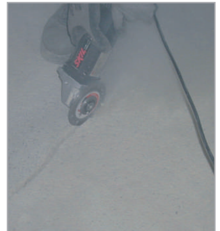
Рис. 8.2. Розшивка тріщин в стяжці кутовою шліфувальною машиною «болгаркою»
