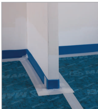
Рис. 4.9. Влаштування акустичної ізоляції плити перекриття шляхом укладання MAPESILENT ROLL, MAPESILENT BAND R та MAPESILENT TAPE
