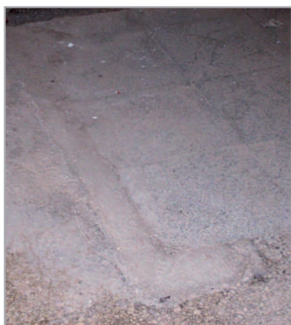
Рис. 7.3. Заповнення штроби між старою та новою стяжкою адгезійним розчином
