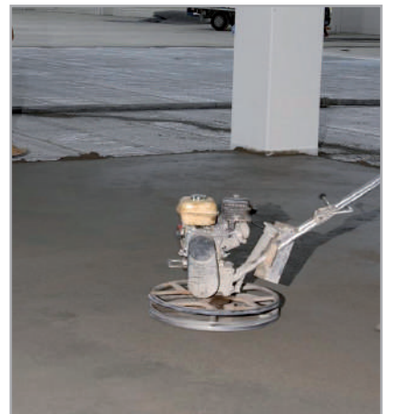
Рис. 7.7. Загладжування поверхні стяжки шліфувальною машиною
