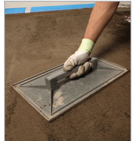
Рис. 7.6. Фінішна обробка поверхні стяжки
