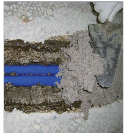
Рис. 8.8. Заповнення штроб розчином MAPEFLOOR EP19
