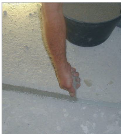
Рис. 8.4. Посипання свіжонанесеного EPORIP піском
