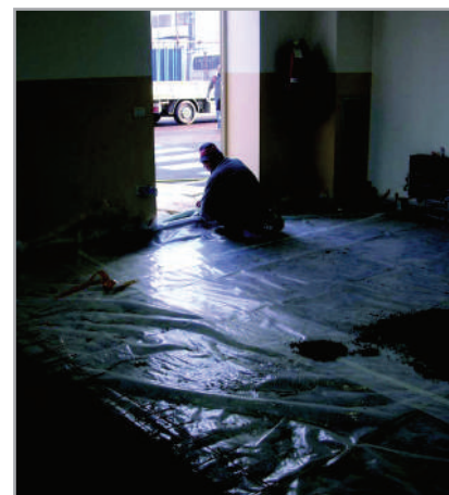
Рис. 4.2. Укладання неадгезійної стяжки на поліетиленову плівку
