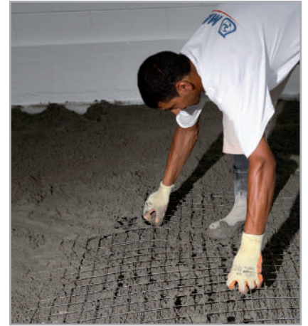
Рис. 7.5. Розміщення оцинкованої металевої сітки всередині шару стяжки
