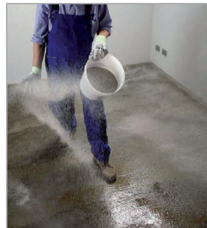
Рис. 8.12 - Посипання поверхні стяжки піском після нанесення шару PRIMER MF
