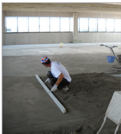
Рис. 6.3. Вирівнювання стяжки з TOPCEM/ TOPCEM PRONTO
