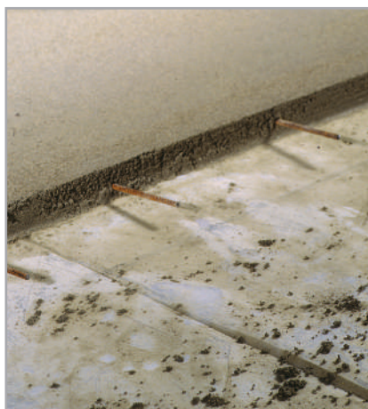
Рис. 7.2. Перпендикулярне обрізання стяжки в місці, де була технологічна перерва під час її влаштування
