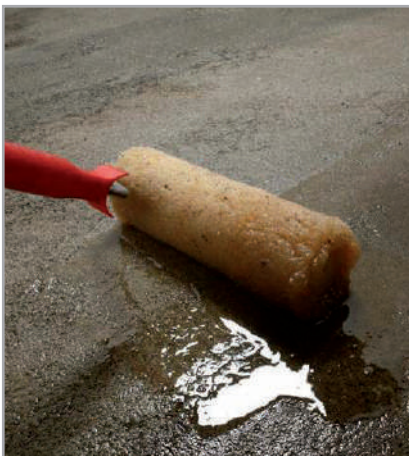
Рис. 8.11. Нанесення PRIMER MF на поверхню стяжки
