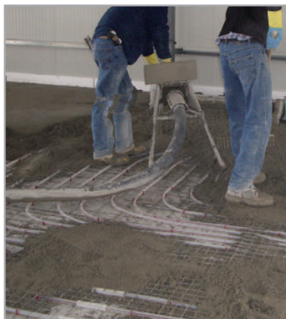
Рис. 4.7. Влаштування стяжки з нагрівальними елементами для системи підігріву підлоги
