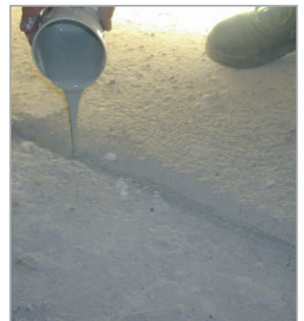
Рис. 8.3. Ремонт тріщин за допомогою EPORIP
