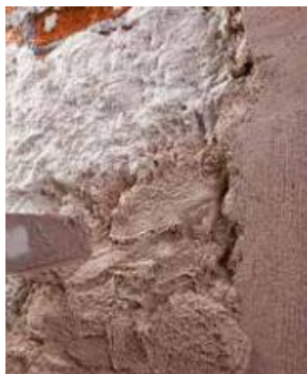
Рисунок 33 – Нанесення розчину Mape-Antique MC поверх шару Mape-Antique Rinzafo
