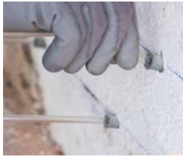
Рисунок 36 – Послідовність робочих операцій при підготовці до ін'єктування для створення гідробар'єру
