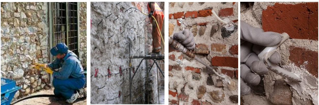
Рисунок 14 – Ін'єктування кладки
