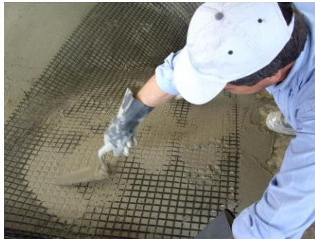
Рисунок 27 – Укладання сітки Maregrid: а – вдавлювання сітки в розчин; б – створення напуску
