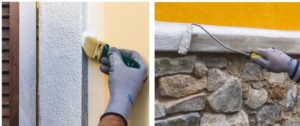
Рисунок 36 – Нанесення захисного шару ручним інструментом
