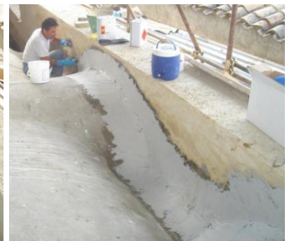
Рисунок 29 – Вирівнювання поверхні та анкерування країв: а – вирівнювання поверхні; б, в – анкерування країв
