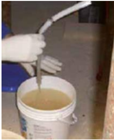
Рисунок 23 – Просочення шнурів смолою MapeWrap 11
