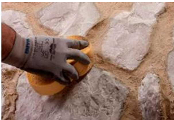
Рисунок 16 – Очищення швів вологою губкою (а) та шліфувальною щіткою (б)
