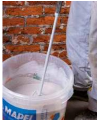
Рисунок 31 – Замішування матеріалу ручним електрозмішувачем зі спеціальною насадкою
