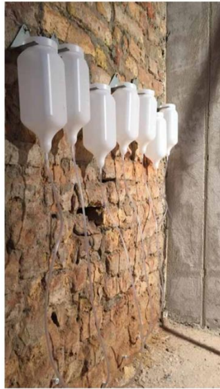
Рисунок 38 – Створення гідробар'єру у кам'яній кладці шляхом ін'єктування матеріалу Mapestop
