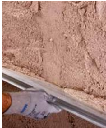
Рисунок 34 – Вирівнювання поверхні правилом
