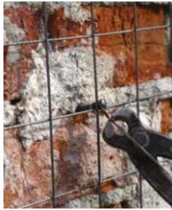
Рисунок 30 – Встановлення металевої оцинкованої сітки
