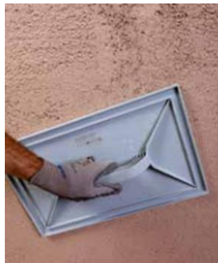
Рисунок 35 – Загладжування та вирівнювання поверхні
