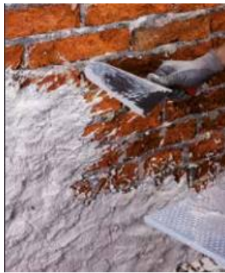
Рисунок 32 – Нанесення розчину Mape-Antique Rinzafo набризком
