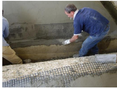
Рисунок 27 – Укладання сітки Maregrid: а – вдавлювання сітки в розчин; б – створення напуску
