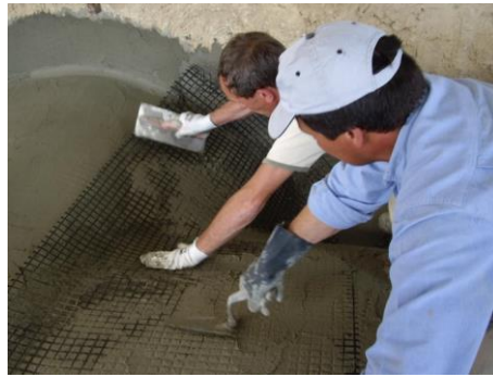
Рисунок 28 – Нанесення другого шару Planitop HDM Maxi
