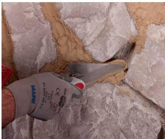
Рисунок 15 – Відновлення швів кладки сумішшю Mape-Antique Allettamento
