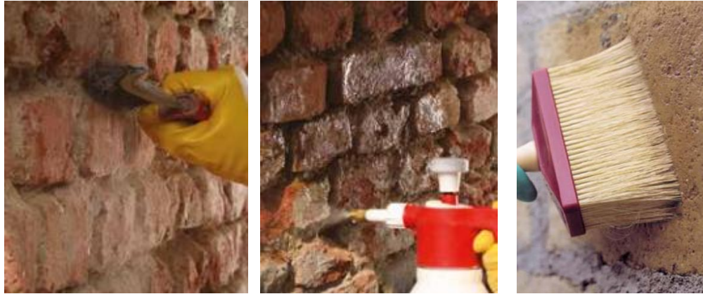
Рисунок 1 – Підготовка поверхні: а – очищення поверхні; б – нанесення грунтовки розпилювачем; в – нанесення грунтовки щіткою
