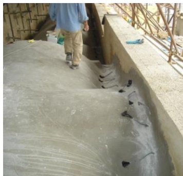
Рисунок 29 – Вирівнювання поверхні та анкерування країв: а – вирівнювання поверхні; б, в – анкерування країв
