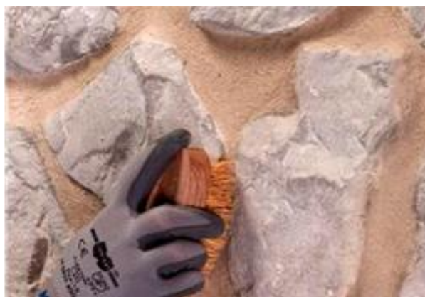
Рисунок 16 – Очищення швів вологою губкою (а) та шліфувальною щіткою (б)
