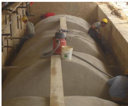
Рисунок 29 – Вирівнювання поверхні та анкерування країв: а – вирівнювання поверхні; б, в – анкерування країв
