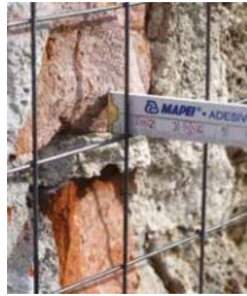
Рисунок 30 – Встановлення металевої оцинкованої сітки
